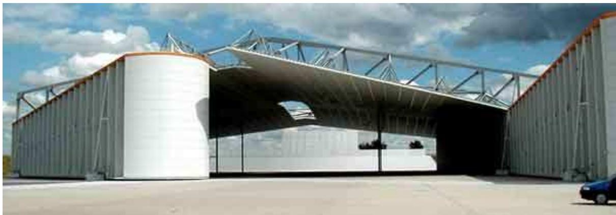
Auf der rückwärtigen Seite der Halle wird der Abgasstrahl durch eine schräge Wand aus Lochblechen nach oben umgelenkt. Im Testbetrieb führte diese Umlenk wand zu lauten Pfeifgeräuschen, die noch in Alsterdorf vernehmbar waren (das Problem wurde durch eine Umkonstruktion der Umlenk wand und zusätzlichem Einbau schalldämmender Materialien gelöst).
