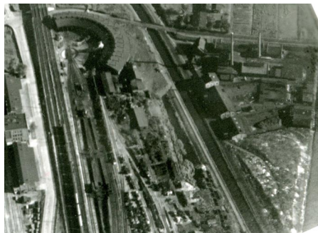
Hist. Luftbild aus 1921/22: Abgelagerte Produktionsrückstände an der Schlachthofstraße (im Bild rechts unten)
