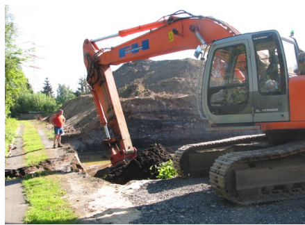
... und Aushub bis zum gewachsenen Boden (Torf)
