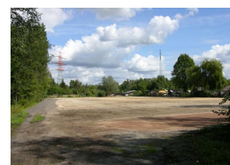
31.8.2006 - Der Deponierückbau ist abgeschlossen
