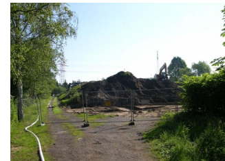
13.6.2006 - Beginn des Rückbaus
