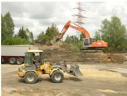
Rückbau der Hügeldeponie ...
