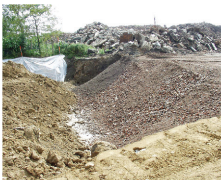
Wiedereinbau von gebrochenem Bauschutt (rechts) und Einbau von Füllboden (vorne / links)
