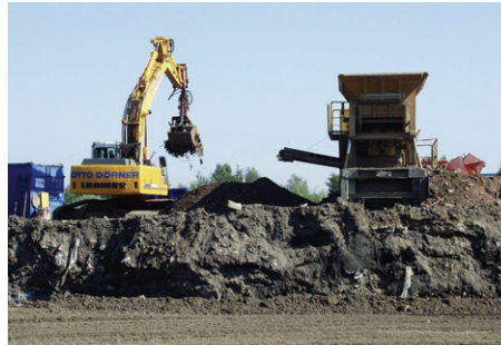
Auffüllungshorizont mit Brech- und Sortieranlage
