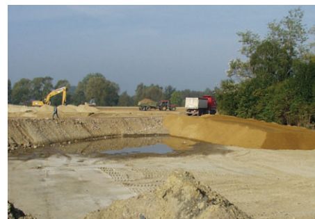
Austausch der Feinfraktion und Aufhöhung des Gesamtgeländes
