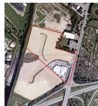
2006: Gesamtgelände mit Entwässerungsgräben entlang zukünftiger Straßen, Regenwasserbehandlungsanlage und Autohaus
