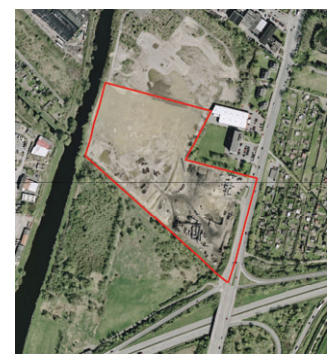
Sanierung der AAB in 2001
