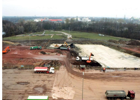
Aushub des Deponiekörpers im Bereich des Baufeldes. Durchschnittlich 3,5 - 4 m unter Gelände stehen die gewachsenen Sande an.
