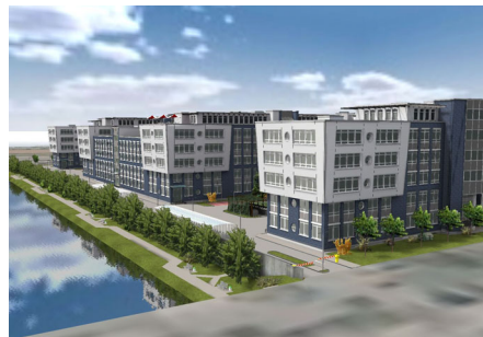
Visualisierung des im Bau befindlichen Bürokomplexes (Quelle: www.hanse90grad.de)
