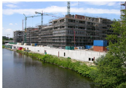
Errichtung des Bürokomplexes mit Tiefgarage am Mittelkanal gelegen
