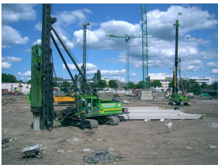
Gründungsarbeiten auf dem Baufeld
