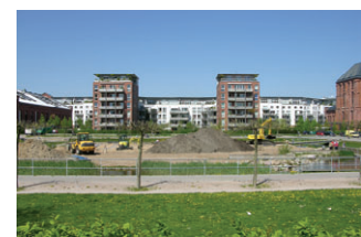
Parkanlage (im Bau) mit nördlicher Wohnbebauung
