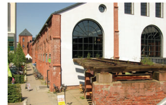
ehem. Gleisanschluss zur Kohlenhalle Süd; heute Fitnesscenter
