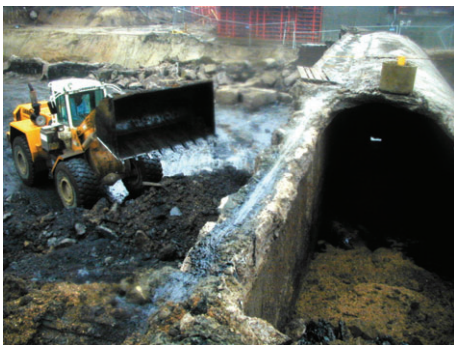
Rückbau der unterirdischen Teer- und Ammoniakgruben
