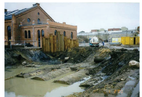
Unterirdische Teer- und Ammoniakgruben (Foto: URS Deutschland GmbH)
