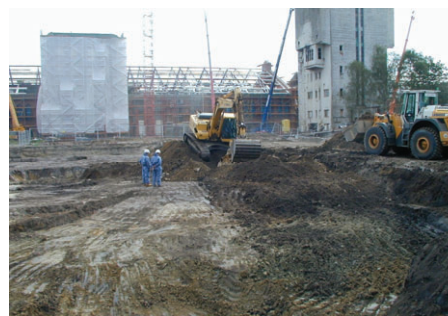
Bau begleitender Bodenaustausch und Sanierung der historischen Bausubstanz
