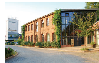
Remise mit (im Hintergrund) Kohlenturm
