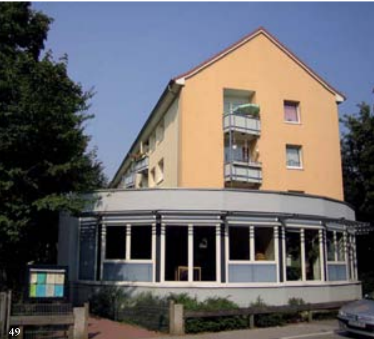
49 Anbau an die Elternschule Wilhelmsburg
