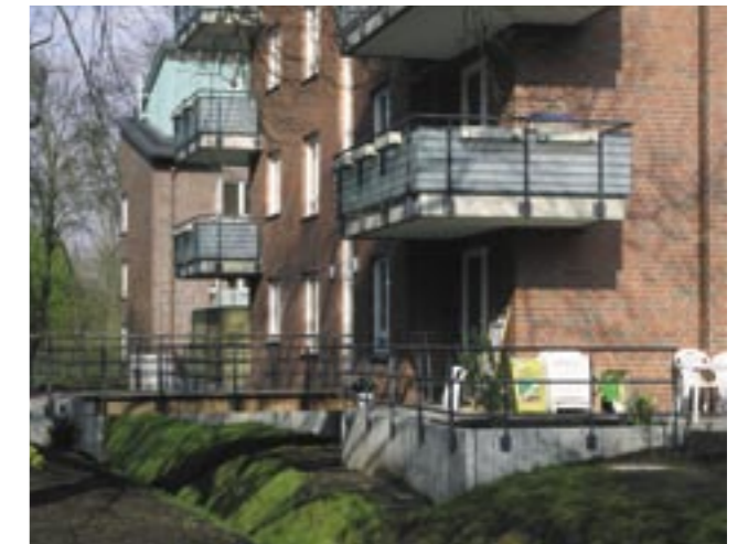
Punkthäuser an den Boltwiesen
