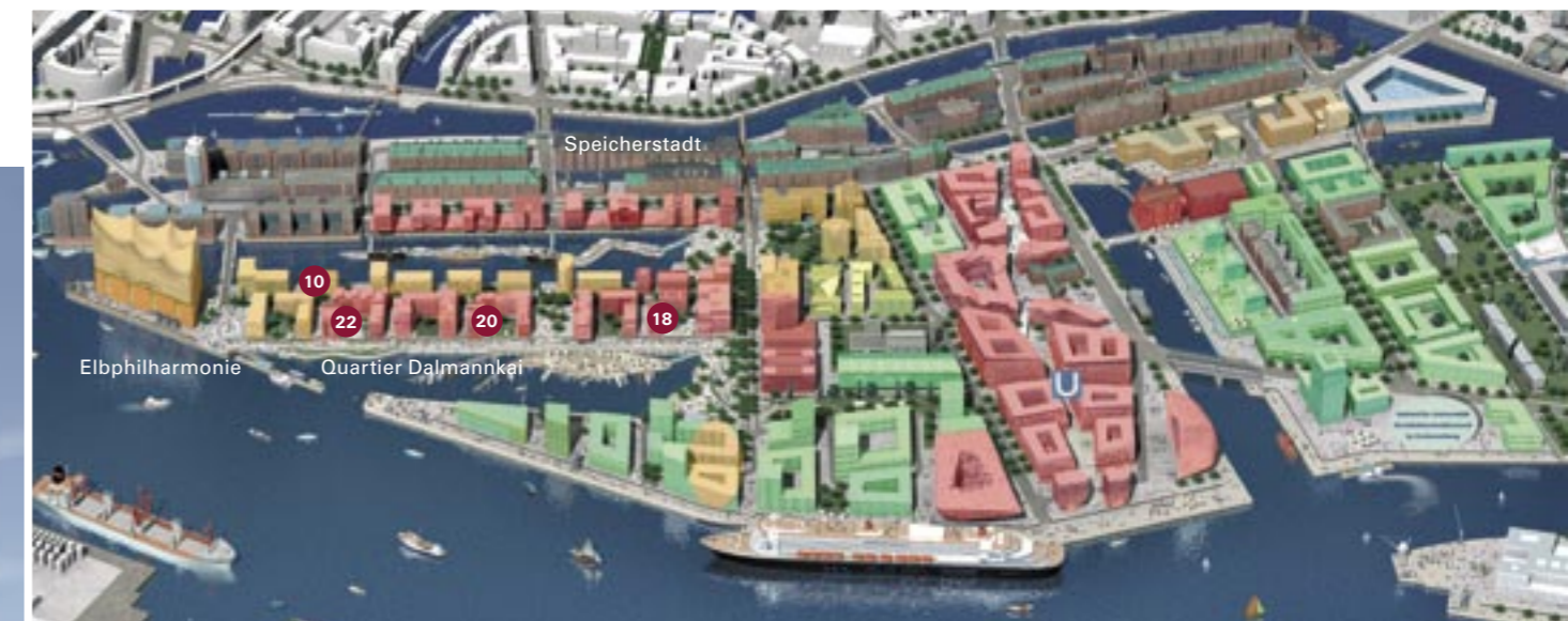
Luftansicht der HafenCity mit dem Quartier Dalmannkai und den Standorten der vorgestellten Projekte auf den Baufeldern 10, 18, 20 und 22
