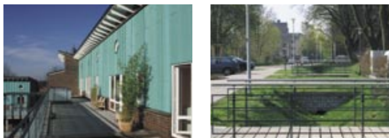
Staffelgeschoss auf den Häusern und Außenanlagen der Baugenossenschaft Hansa
