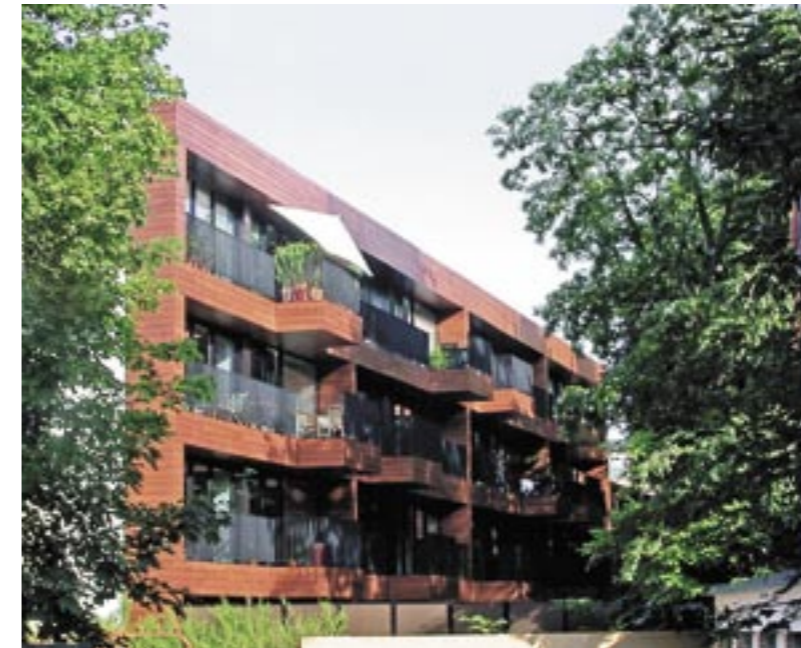
Zustand des Gebäudes vor dem Umbau
