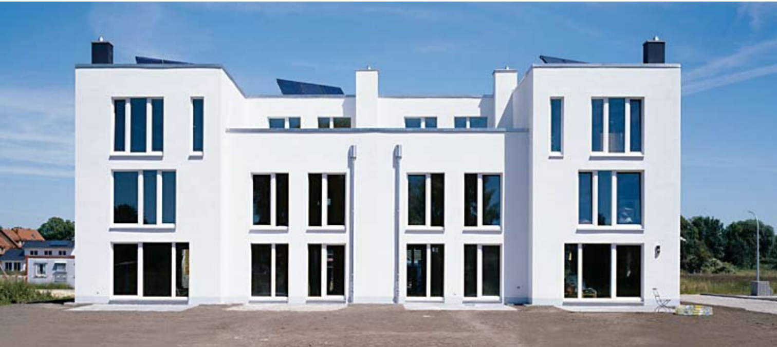
Passiv-Reihenhaus in Hamburg-Wilhelmsburg: Südseite, große Fensterflächen für solare Energiegewinne
