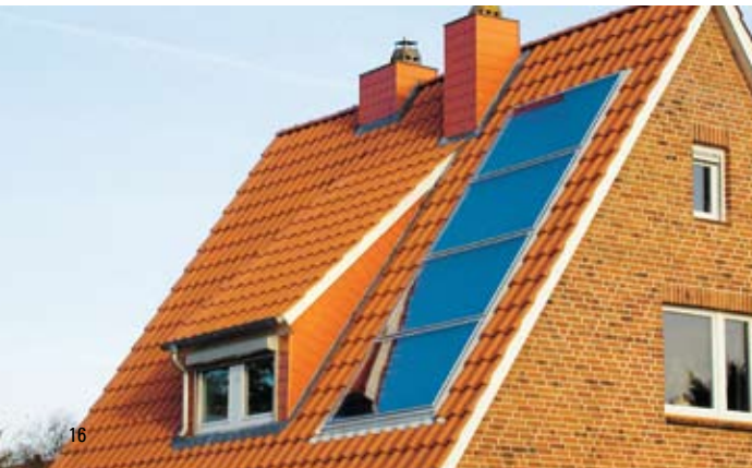
Indachmontage von Flachkollektoren
