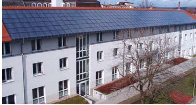
Große solarthermische Anlage auf Altenpflegeheim (Quelle: solifer)
