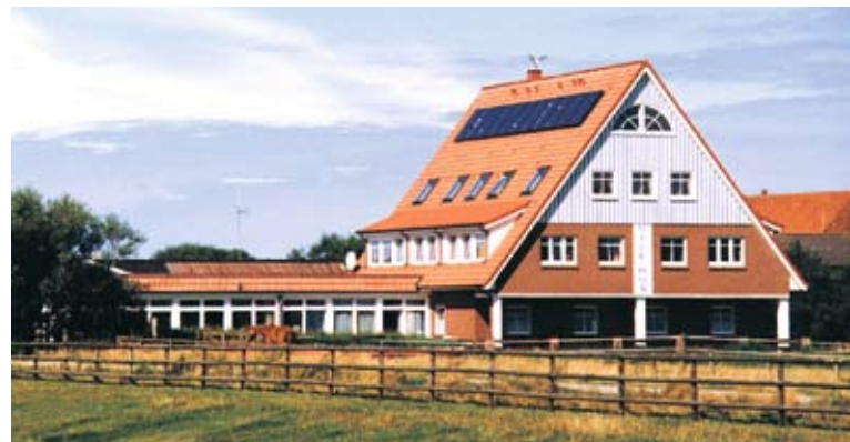
Kollektoranlage zur Warmwasserbereitung für die Pension Nige-Hus auf der Insel Neuwerk
