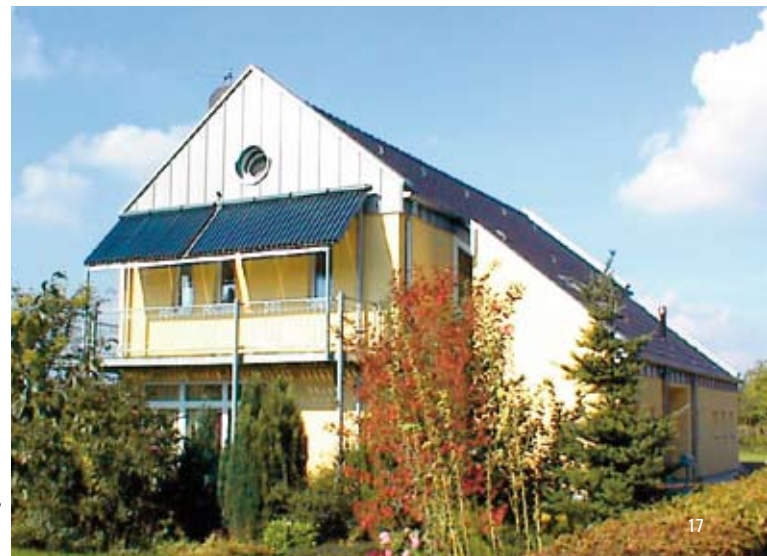
An der Fassade montierte Kollektoren
