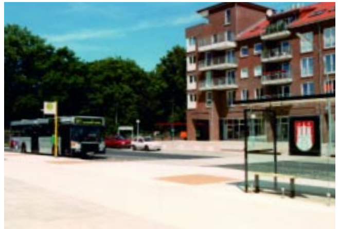
Abb. 37: Bushaltestelle für neue Siedlung Burgwedel
