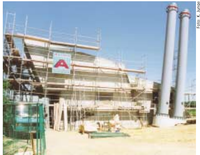
Das Blockheizkraftwerk im Bau
