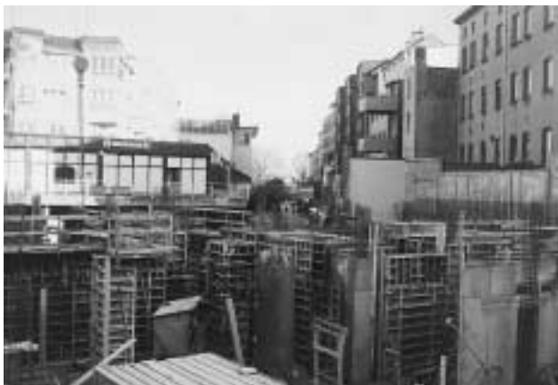
Hier entsteht das Cinemaxx
