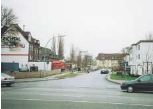
Hergerichtete Erschließungsstraße mit neuem Gebäudebestand
