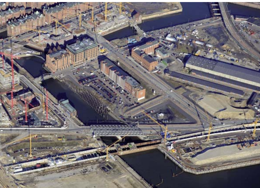
Noch befinden sich nur Freiflächen und Bestandsbauten im Elbtorquartier, in seinem Süden wird bereits an der neuen U-Bahn U4 gebaut. Ab Ende 2009 entsteht hier mit der HafenCity Universität der erste Neubau des Gebiets
