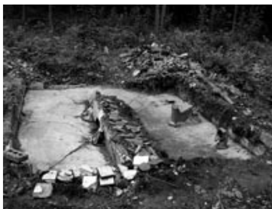
Freilegung Toiletten Ende
