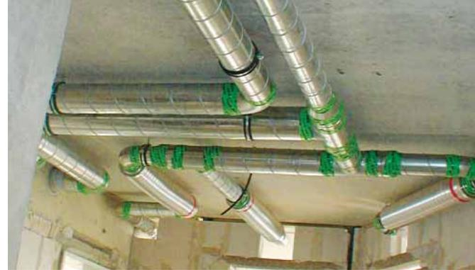
Zu- und Abluftkanäle unter der Decke im Flur.
