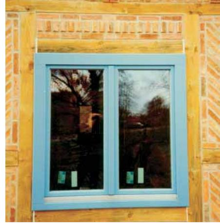
Die Fenster sind in den meisten Wohngebäuden die Bauteile mit dem geringsten Wärmeschutz. Zudem sind ältere Fenster im Fugenbereich häufig undicht. Dabei gilt grundsätzlich: Fenster müssen dicht schließen, Undichtheiten im Fugenbereich führen zu Zuglufterscheinungen und können auch zu Feuchtigkeitsschäden im Bereich der Laibungen führen. Der erforderliche Luftaustausch muss über das Öffnen der Fenster oder eine Anlage zur kontrollierten Lüftung (siehe hierzu Seite 28) erfolgen.
