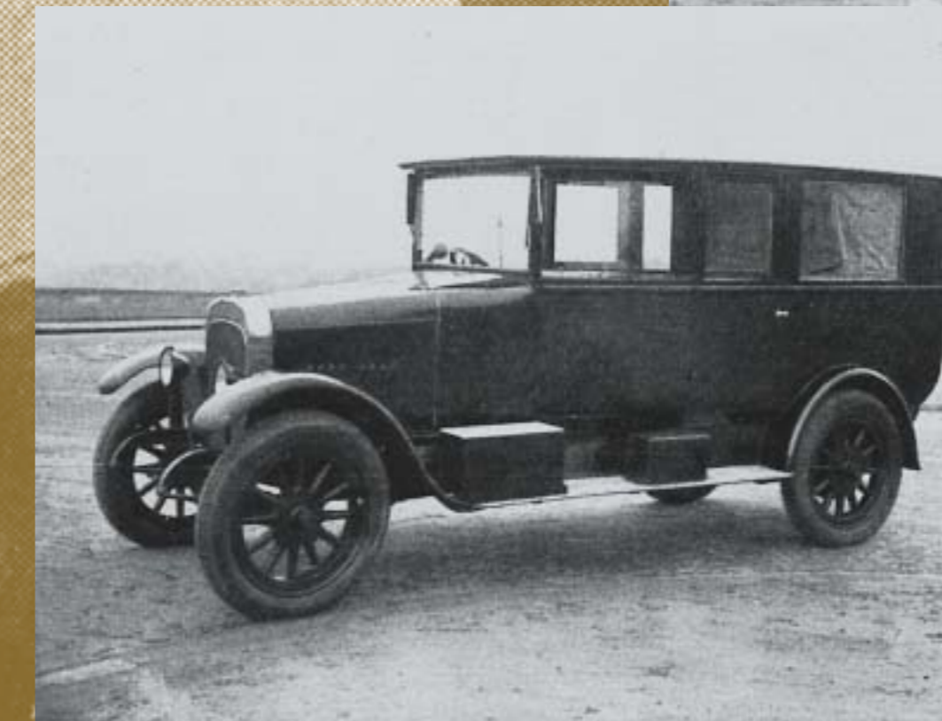
Milchuntersuchungskraftwagen der Hamburger Polizeibehörde, 1928 Der Kraftwagen ist eine Sonderanfertigung und ähnelt äußerlich einem normalen PKW. Dadurch eignet er sich vor allem in ländlichen Gebieten sehr gut für unangekündigte und überraschende Probenentnahmen. Trotz des geringen Rauminhaltes enthält das kleine Labor alles, was für Milchuntersuchungen benötigt wird. (Institut für Hygiene und Umwelt)
