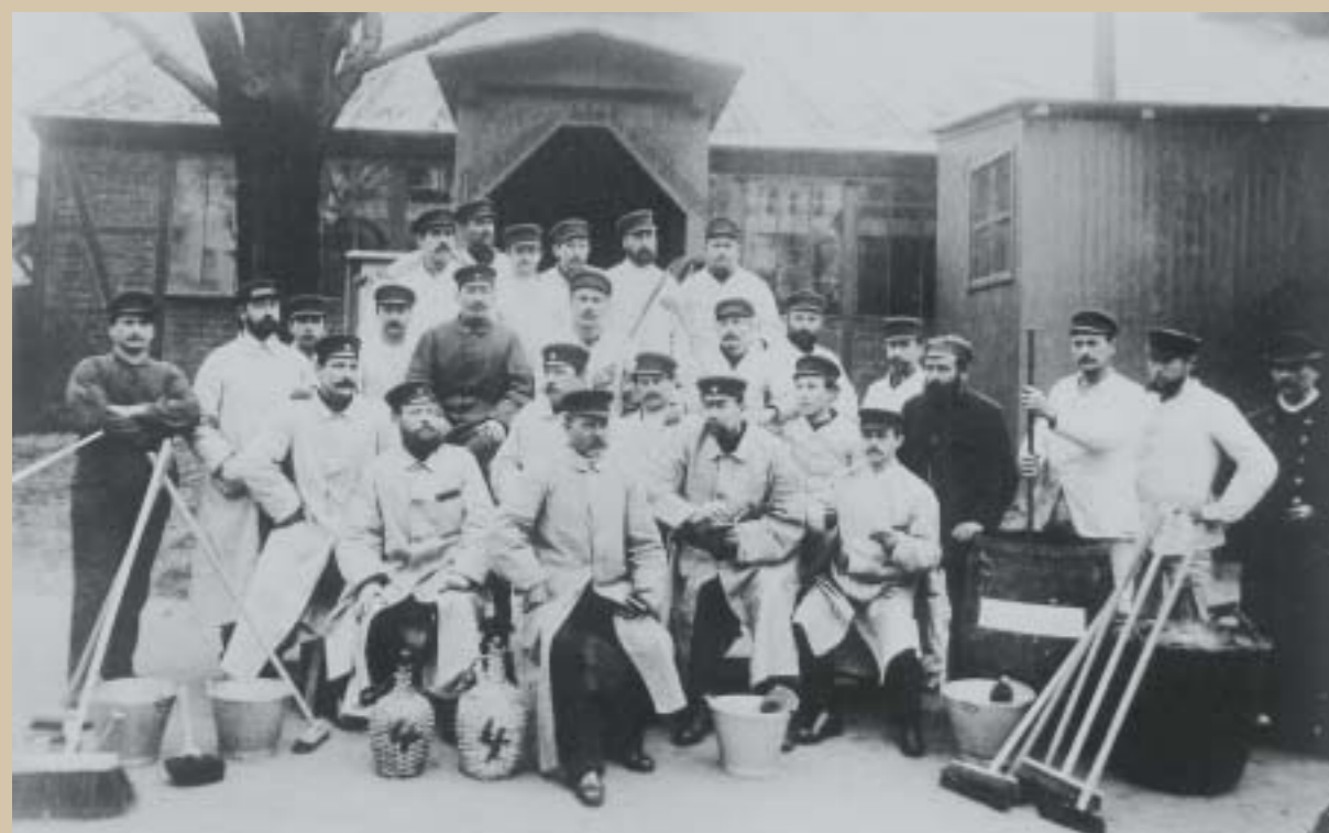
Desinfektionskolonne vor der Desinfektionsanstalt im Exerzierschuppen Holstentor, 1892 (Hamburger Wasserwerke)
