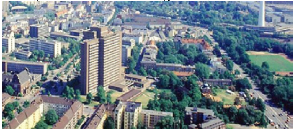
Abbildung 31: Geomatikum mit 21 Geschossen (Quelle: BSU)
