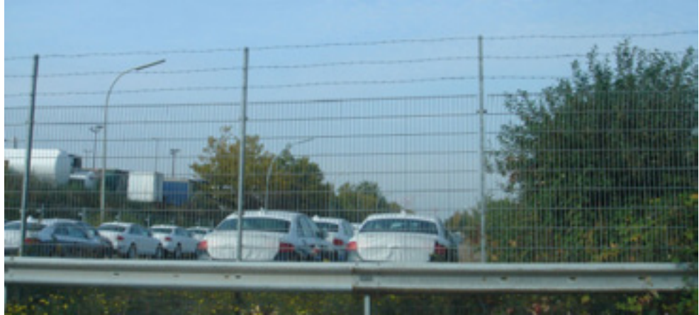
Abbildung 123: Abtrennung der Hafennutzung durch Stahlzaun
