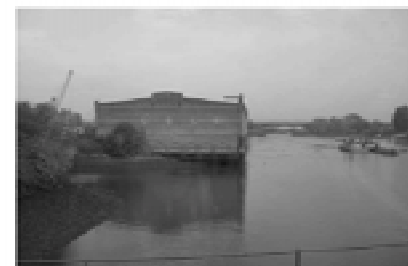
Lagerhaus G, Blick von Süden
