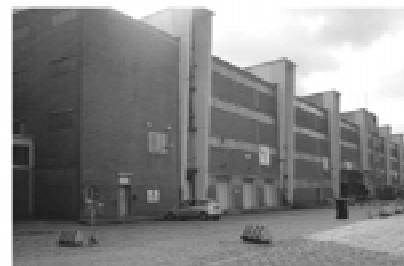
Lagerhaus F, Blick aus Richtung Deutscher Straße
