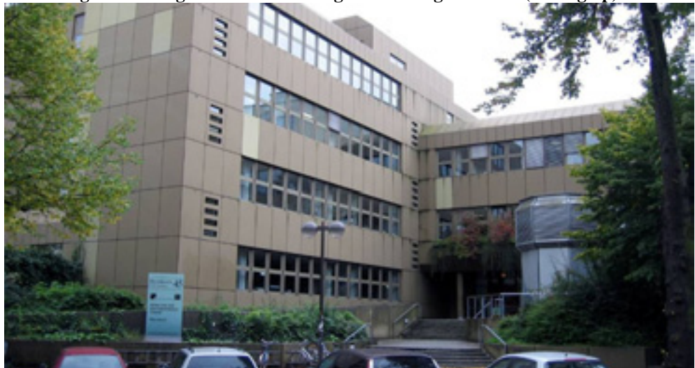
Abbildung 35: Keine gewerbliche Nutzung in den Erdgeschossen (Foto: gmp)
