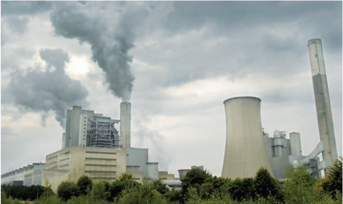
Das Kohlekraftwerk in Neurath gehört zu den klimaschädlichsten Anlagen Europas. Der hohe CO 2 -Ausstoß bei der Stromgewinnung aus Kohle ist eine Ursache für den Klimawandel. © WWF-Canon / Andrew Kerr
