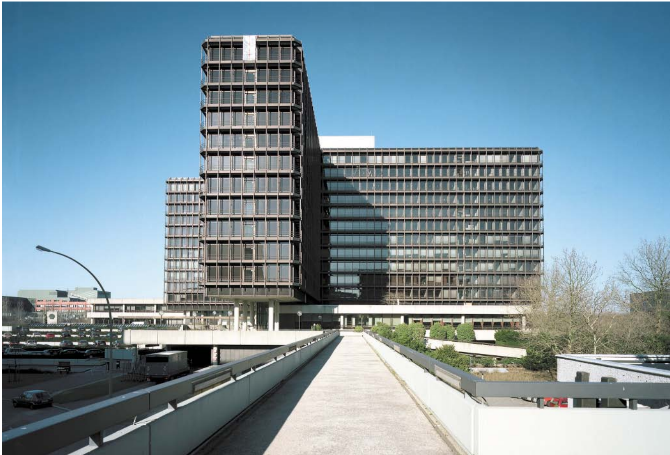
Verwaltungsgebäude der Shell AG (ehemals), von Gerkan, Marg & Partner, 1973-75 (Foto: LMZ HH - Sabine Ganczarsky)
