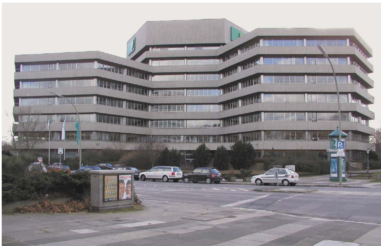
Verwaltungsgebäude der Deutschen BP AG, Kraemer, Sieverts & Partner, 1968-71 (Foto: Denkmalschutzamt Hamburg - AH)
