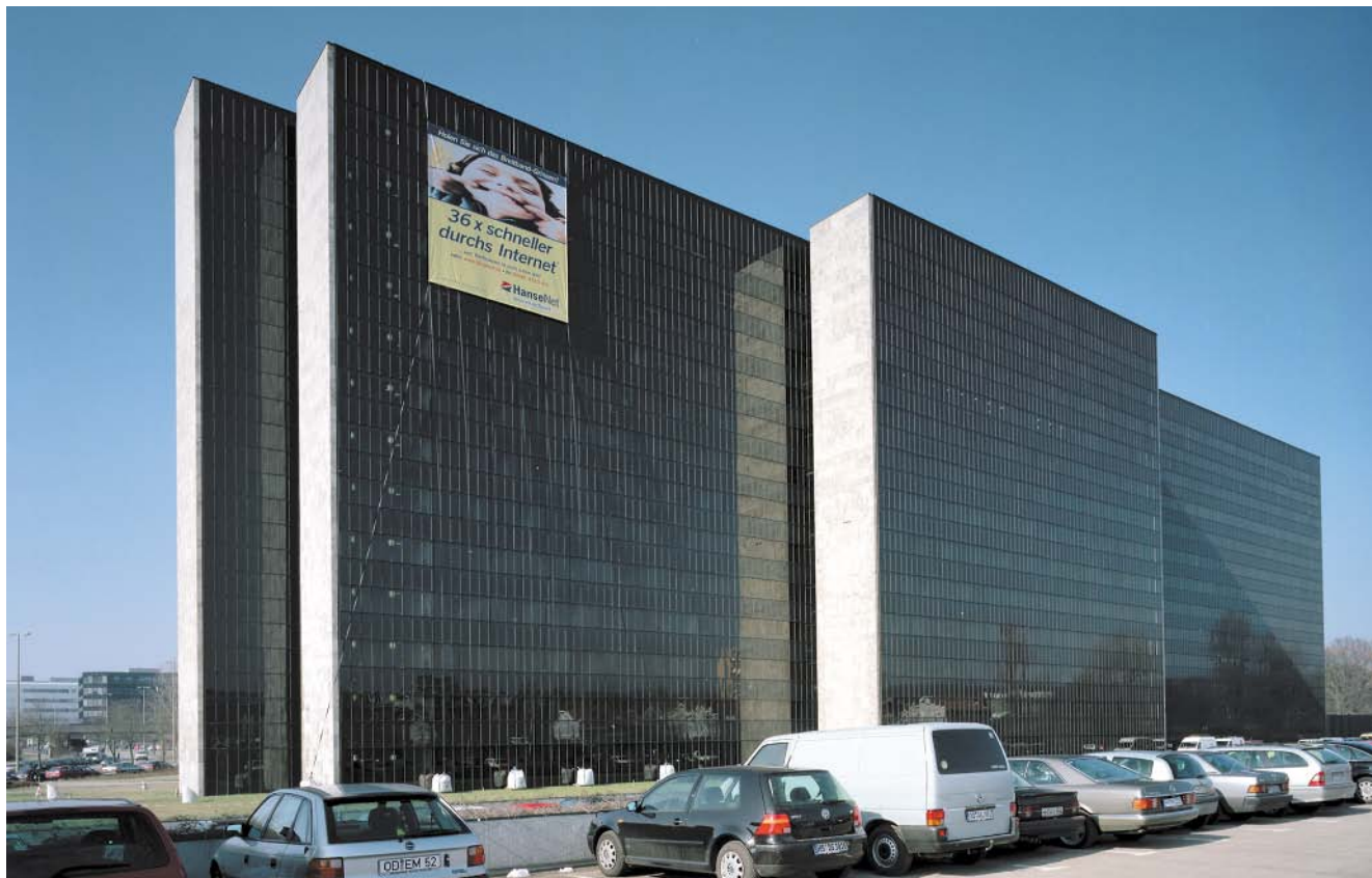
Verwaltungsgebäude der Hamburgischen Elektrizitäts-Werke AG (HEW), Arne Jacobsen, 1965-69 (Foto: LMZ HH - SG)
