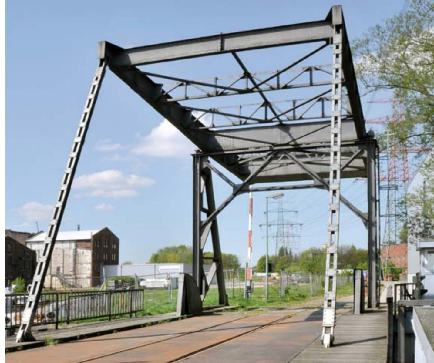
Holzhafenklappbrücke. Die Zugbrücke mit kombinierter Schiene-Straße-Fahrbahn wurde 1929/30 als Ersatz für die gasbetriebene Drehbrücke von 1882 gebaut, die bis dahin die Konsul-Ritter-Straße mit dem Lotsekai verband. Die Zugbrücke ist von herausragender technikgeschichtlicher Denkmalbedeutung, da sie die einzige erhaltene schienenführende Klappbrücke Hamburgs ist.
