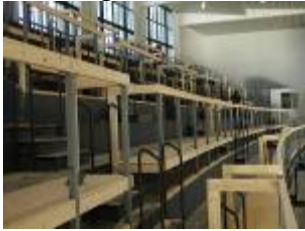
Bild 18: Alte Stadthalle im Umbau
