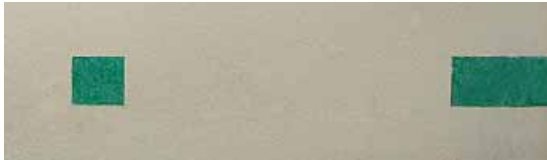
Abb. 1 Laeishalle, Kleiner Saal, Befunduntersuchung, Freilegungsschnitt Wand Ausgang
