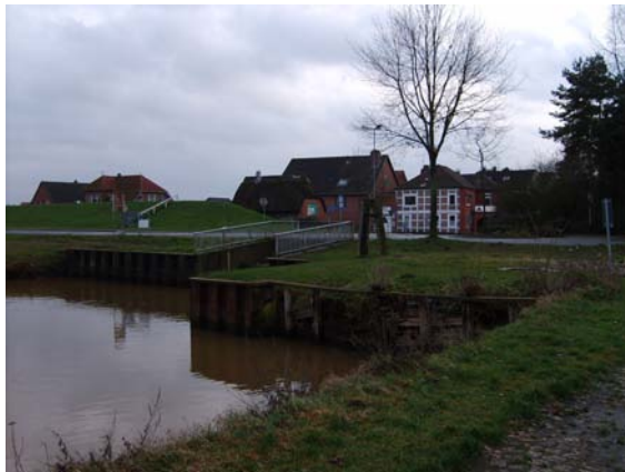
Pumpwerk in Borstel
