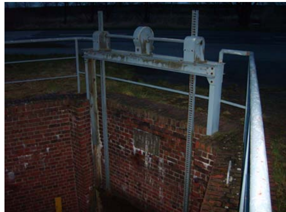
Schleuse (Siel) östlich von Borstel
