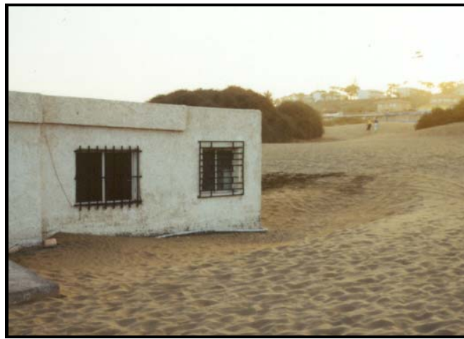
Figura VI.4. Pasillo de sombra eólica generado tras el puesto de la Cruz Roja
