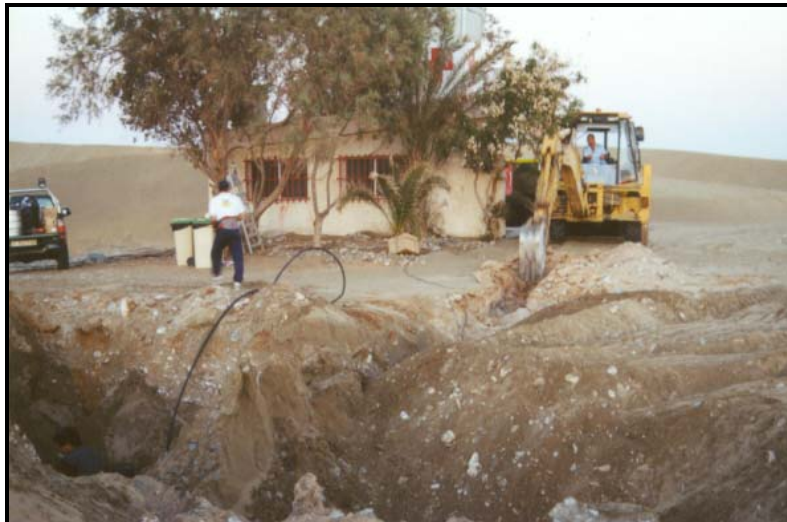
Figura VI.20. Excavación realizada para "extraer" un kiosco
