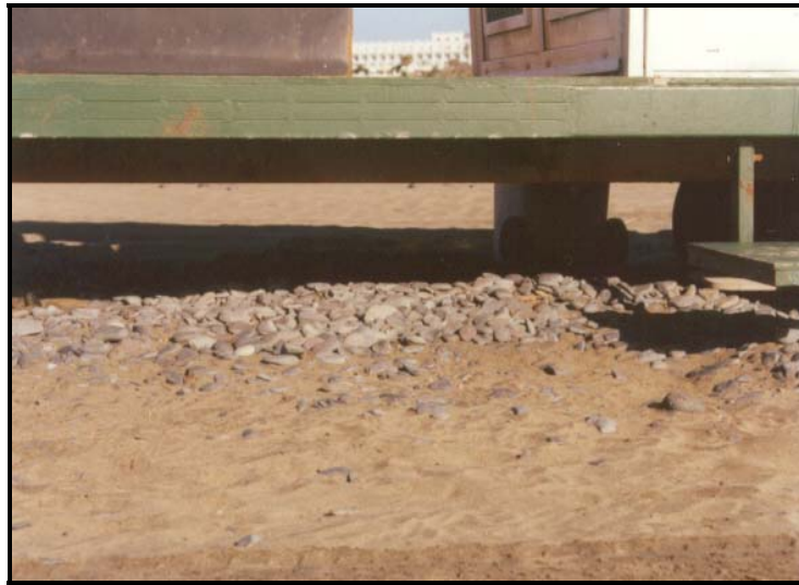
Figura VI.8. Parte baja del kiosco 6
