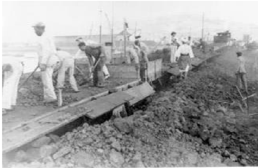
Trabajadores construyendo las vías del tren para el transporte del mineral: un jornalero agrícola ganaba de 2,50 a 3 pesetas diarias; un minero o un obreo de obras públicas, unas 4 pesetas.
