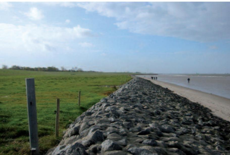
Auf eine höhere Belastung des Deckwerks gibt es gestufte Antworten. Man kann zunächst die üblichen Instandsetzungsarbeiten in kürzeren Intervallen vornehmen. Wenn dies nicht reicht, sollte die bauliche Auslegung des Deckwerks geprüft und ggf. den höheren Belastungen angepasst werden. Dies geschieht üblicherweise durch die Wahl größerer oder schwererer Steine oder durch ihre Verklammerung.
