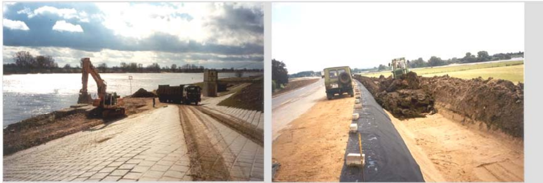
Der größte Teil der EU-Mittel wird in der Maßnahme Küstenschutz (Förderschwerpunkt B) eingesetzt: Deich- und Deckwerksarbeiten am Altengammer/Neuengammer Hauptdeich.
