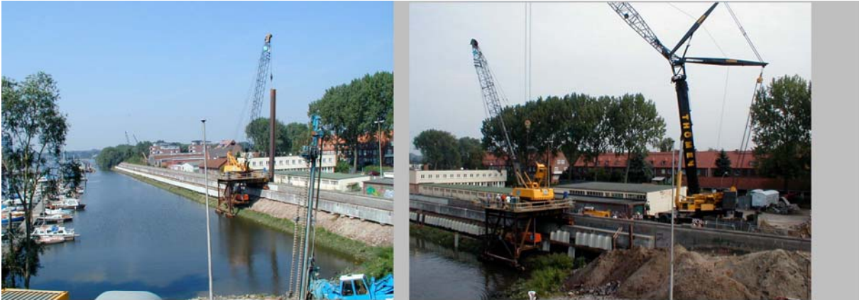
Dem Hochwasser Grenzen setzen Rammgerüst und Errichtung von Uferwänden als Küstenschutzmaßnahme in Finkenwerder.
