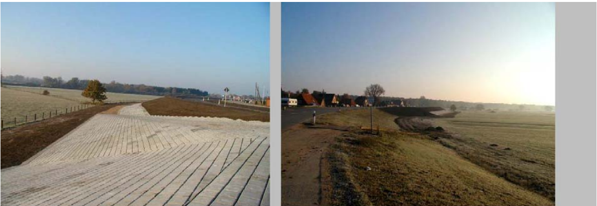
Zum Küstenschutz gehören sichere Deiche. Erhöhter Bereich mit neuem Deichwerk und Deichüberfahrt am Borghorster Deich.
