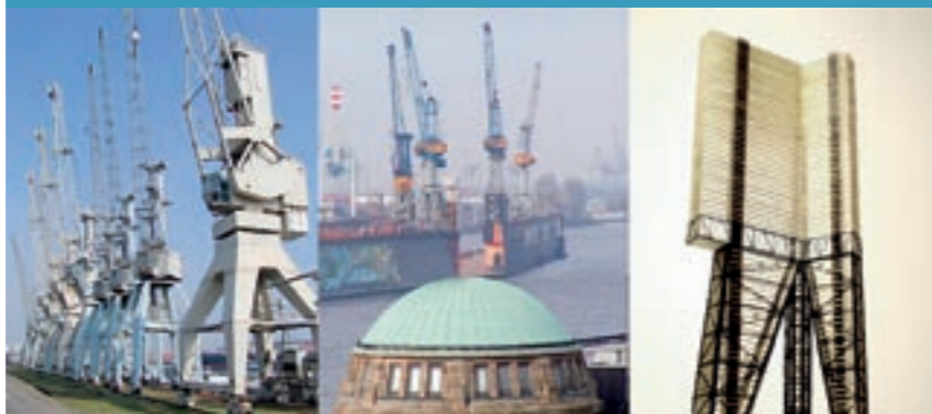
Die mit ihren offenen Tragstrukturen betont konstruktive Architektur zeigt eine assoziative Nähe zu den Kran- und Brückenbauwerken des Hamburger Hafens
