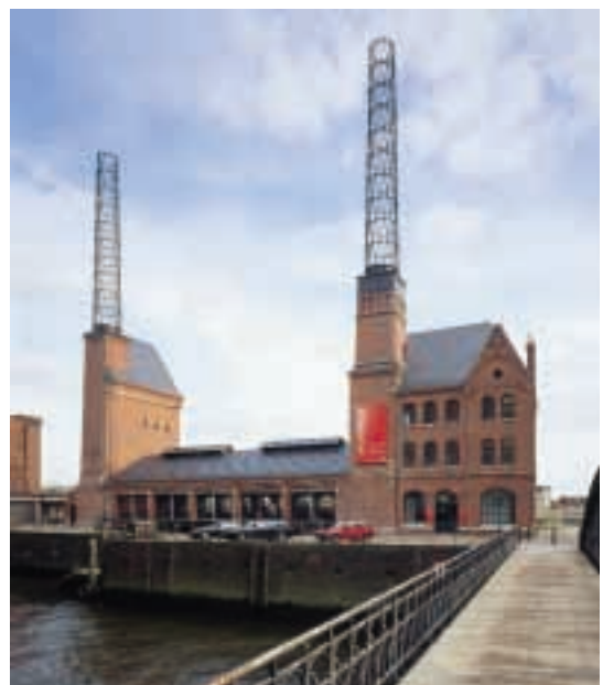
Das Kesselhaus wurde im Jahr 2000 nach den Entwürfen des Architekturbüros von Gerkan, Marg und Partner umgebaut
