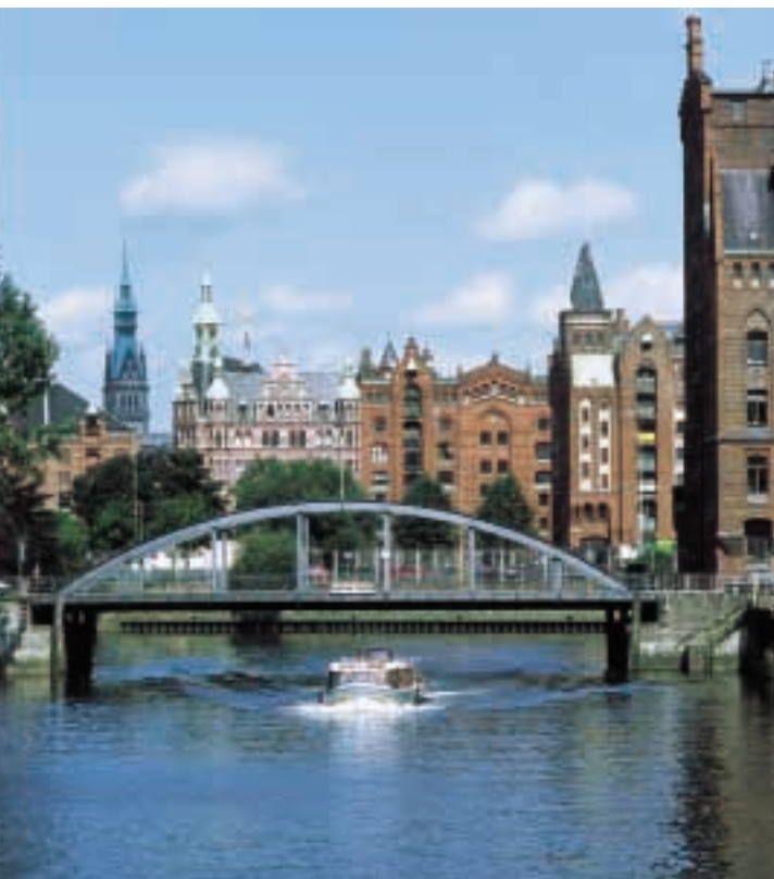
Am Brooktor/St. Annen liegt das Zentrum der Speicherstadt mit dem Hauptverwaltungsgebäude der Hamburger Hafen- und Lagerhausgesellschaft AG (HHLA), dem „Rathaus der Speicherstadt“
