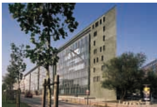
Bürohaus VTG-Center an der Amsinckstraße von den Architekten Léon & Wohlhage
