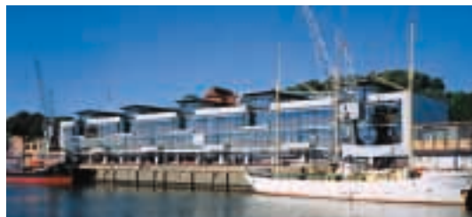
Bürogebäude Elbkaihaus, von Gerkan, Marg und Partner
