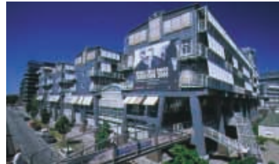
Verlagsgebäude Gruner + Jahr, Otto Steidle und Uwe Kiessler mit Schweger + Partner
