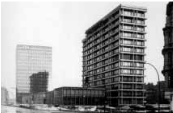
Spiegel-Hochhaus (Werner Kallmorgen, 1967-1968), Höhe 48 Meter
