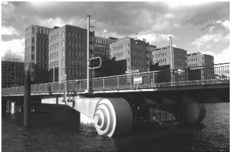
Die neue Klappbrücke über den Sandtorhafen ergänzt das Straßennetz The new folding bridge across Sandtorhafen completes the road-network
