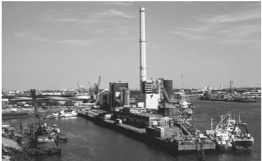
Der Bereich Grasbrookhafen – das Heizwerk wird bis 2002 abgeräumt The Grasbrookhafen area - the power station will be demolished in 2002
