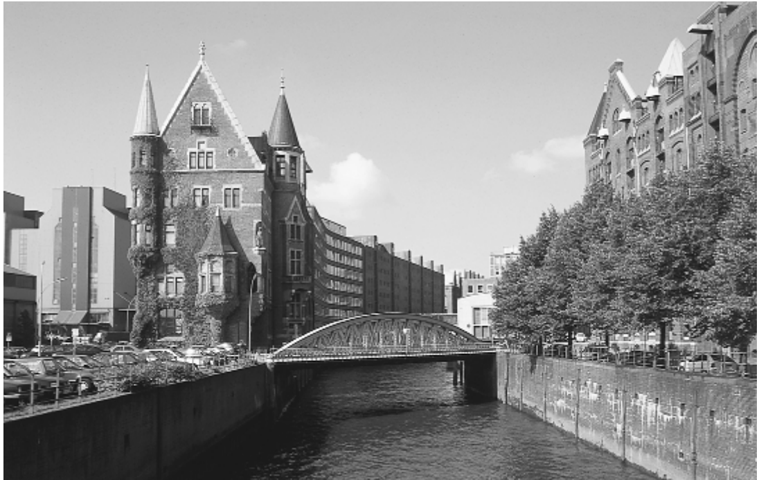
In der dicht bebauten Speicherstadt schaffen Wasserflächen Abstand zwischen den Gebäuden Canals generate space between buildings in the densely developed Speicherstadt
