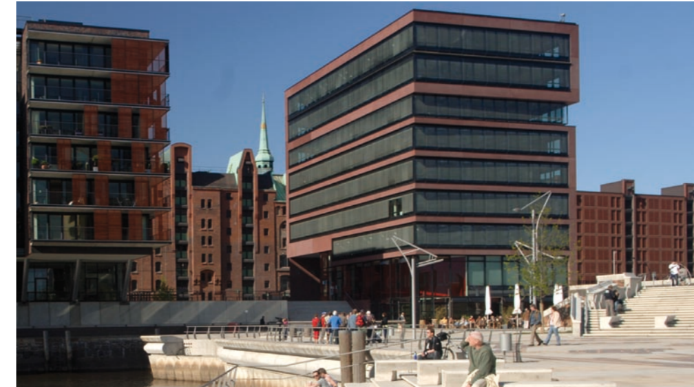
Das Restaurant ChilliClub im Sockelgeschoss des Bankhauses Wölbern
