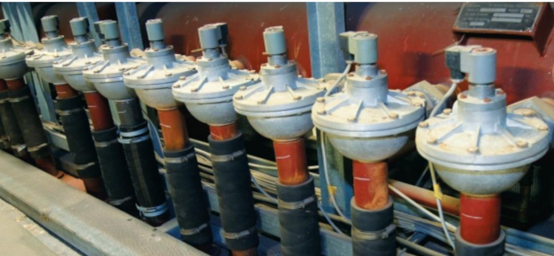
Abblaseeinrichtung der Filterschläuche, die durch Druckluft betrieben wird (Müllverwertung Borsigstraße GmbH).
