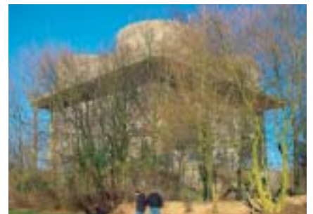
Monumentales Relikt aus dem 2. Weltkrieg, der Bunker an der Neuhöfer Straße / Monumental relict from the Second World War, the bunker on Neuhöfer Strasse
