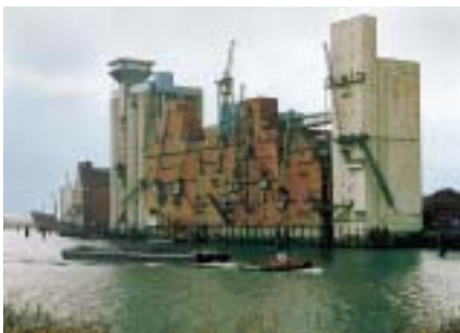
Getreidesilo am Reiherstieg / Grain silo on Reiherstieg
