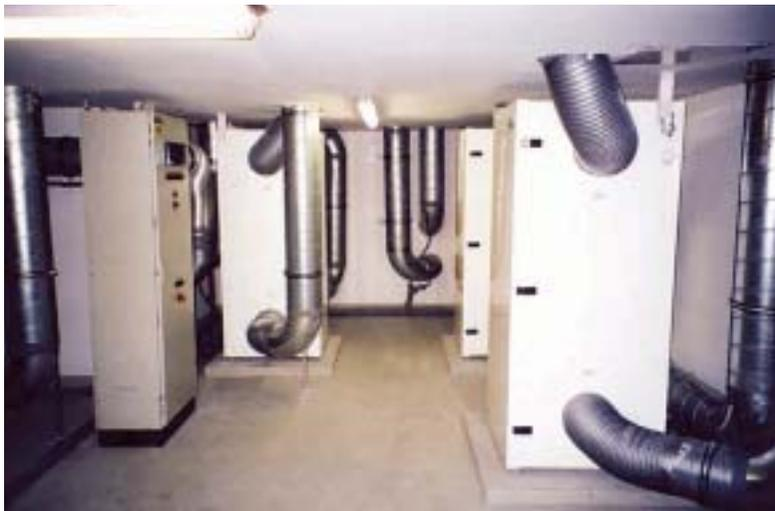
Die 5 Kreuzstrom-Wärmetauscher befinden sich im Haustechnikraum im Keller.
