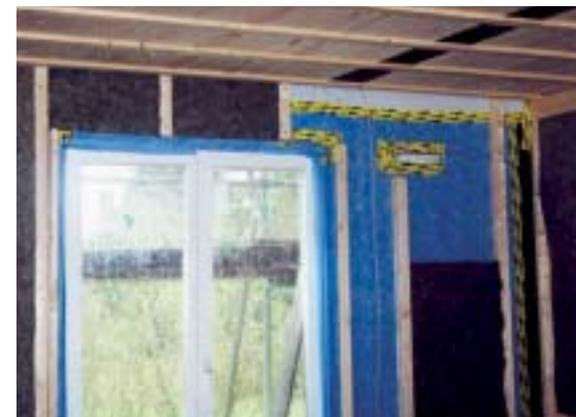
Die Zuluftöffnung sollte möglichst in Fensternähe und Sturzhöhe eingebaut werden. Dabei ist besonders auf den luftdichten Anschluss zu achten.
