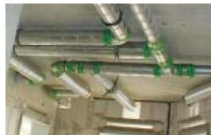
Zu- und Abluftkanäle unter der Decke im Flur.
