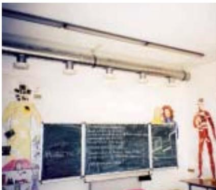
Die Regelung der Anlage erfolgt raumweise über CO<sub>2</sub>-gesteuerte Fühler.
