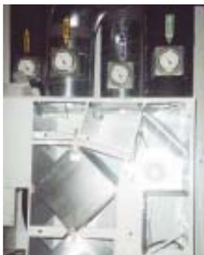
Im Technikraum im Obergeschoss befindet sich für jeden Raum ein Wärmetauscher.
