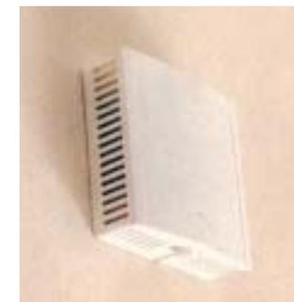
Der Abluftventilator im Bad und WC kann z.B. an einen vorhandenen Schacht angeschlossen werden. Der Betrieb sollte über eine Zeitschaltuhr mit bedarfsgerechter Programmierung oder eine feuchtegeführte Regelung erfolgen. In Mehrfamilienhäusern sind die Brand- und Schallschutzanforderungen zu beachten.
