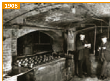
Kupferelektrolyse unter dem Kellergewölbe der Elbstraße mit Betriebsleiter Hagemann und Meister Geissel
