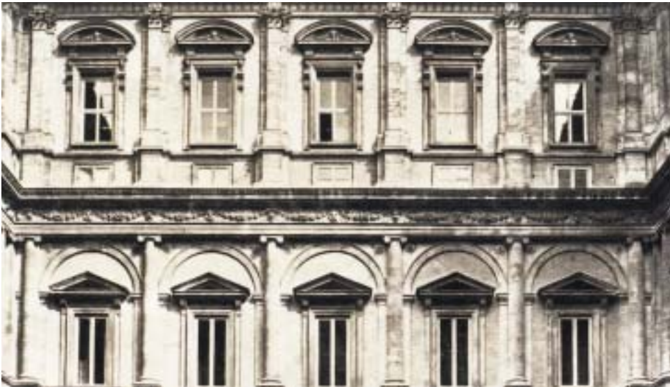
Abb. 101: Palazzo Farnese, Innenhof-Fassade
