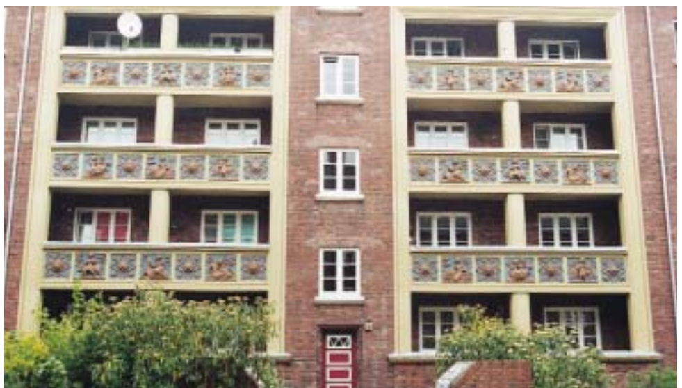
Abb. 158: Loggiafassade am Etagenhaus Mergellstraße 18/Harburg
