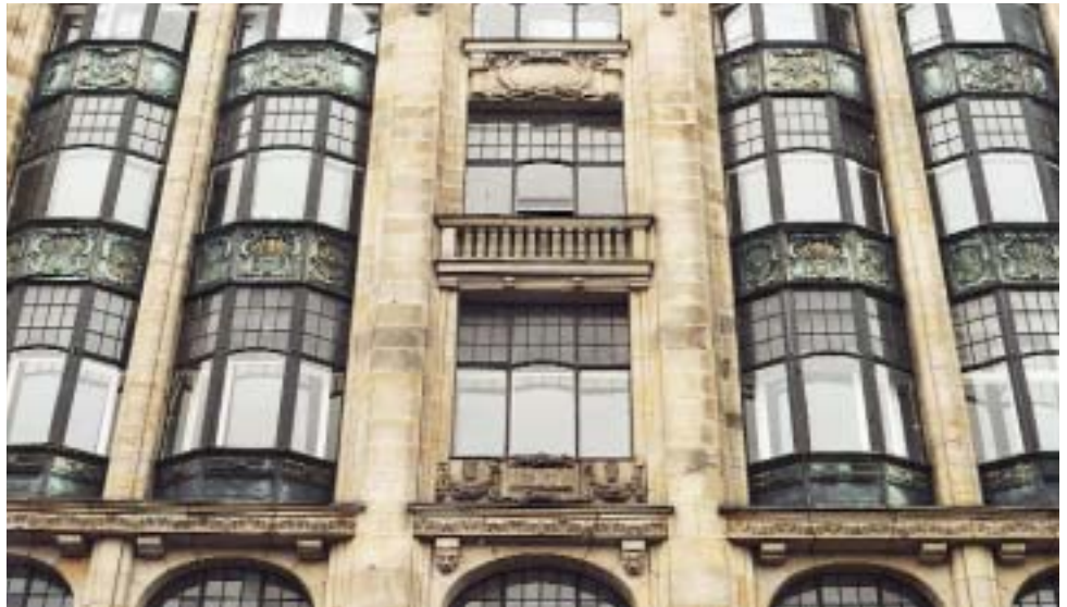
Abb. 152: Bay-Window-Fassade am Kontorhaus Alsterhaus
