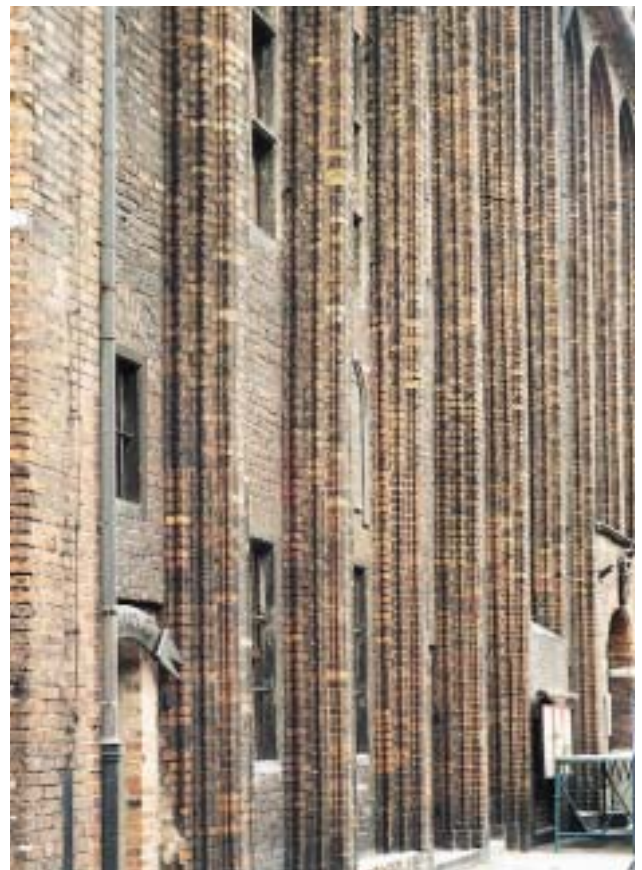
Abb. 135: Pfeilerfassade am gotischen Rathaus in Thorn/Westpreußen
