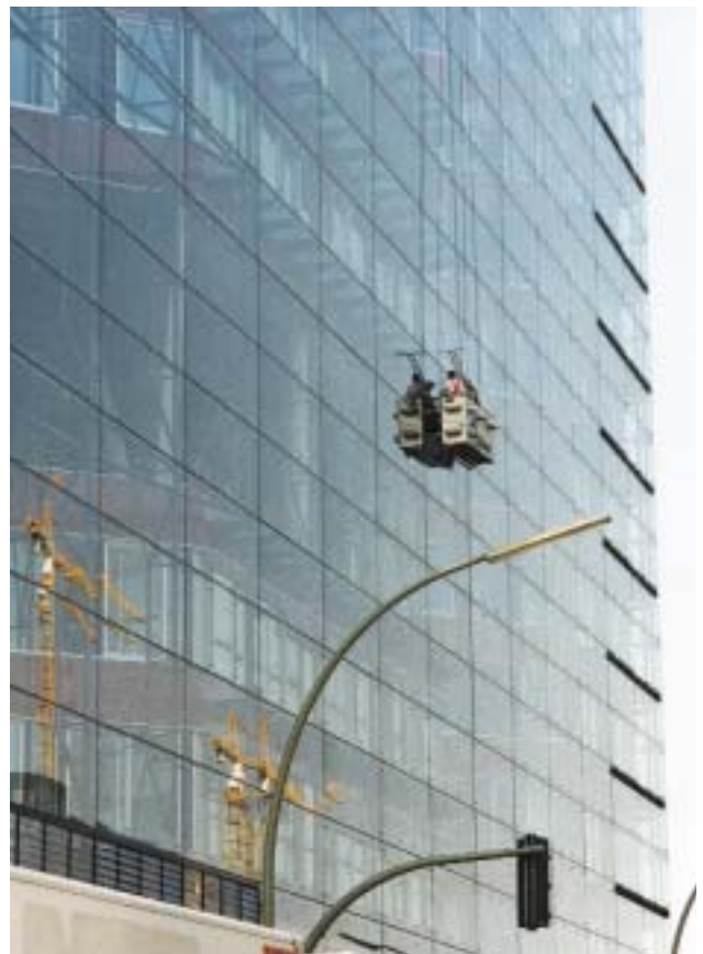
Abb. 151: Die äußere Glashülle des Doppel-XX-Hauses in Hammerbrook
