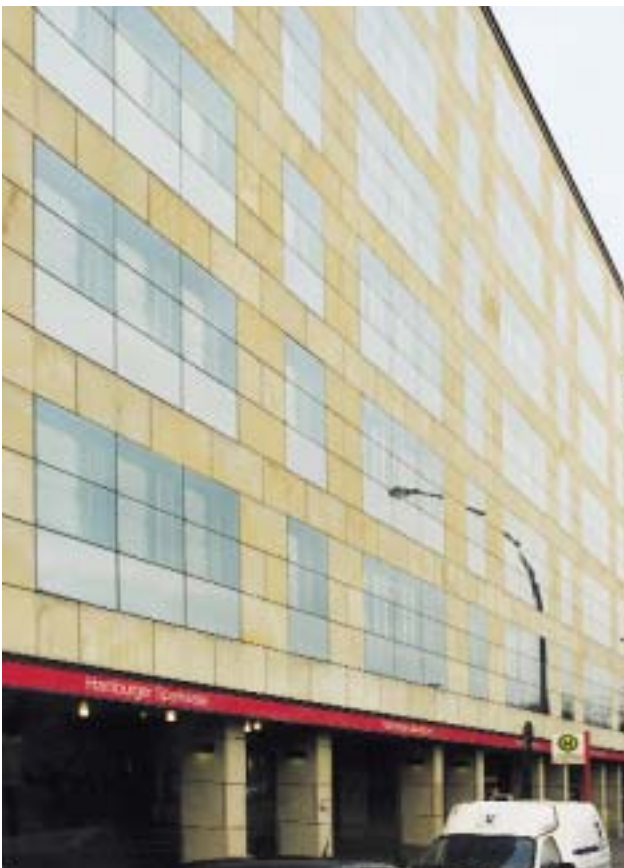
Abb. 150: Glas und Stein in einer absolut ebenen Fassadenfläche: Haus der Haspa gegenüber der Galerie der Gegenwart
