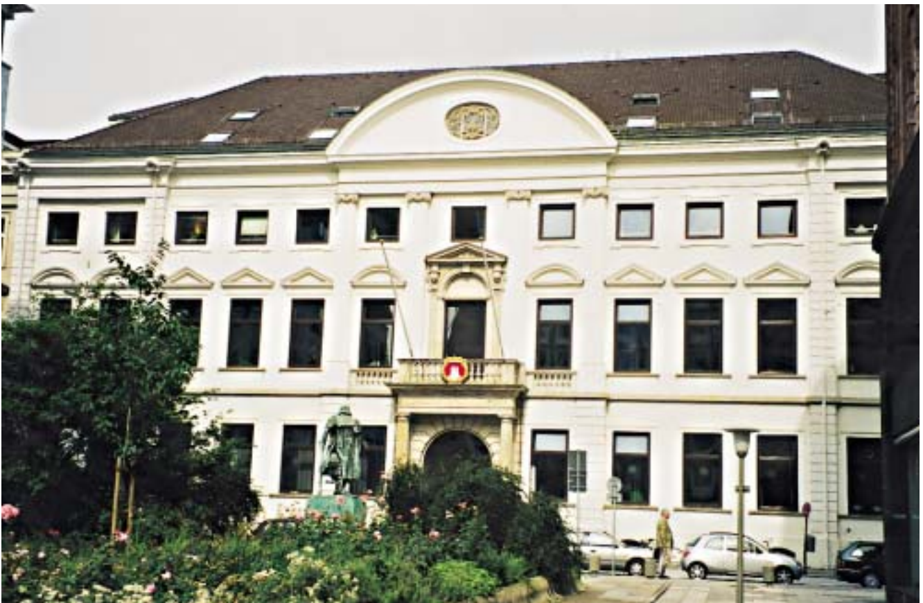
Abb. 23: Die Fassade im Jahr 2002
