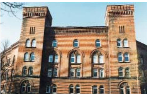
Abb. 207: Ecktürme zeichnen die Straßenknicks: Preussische Kaserne in Altona
