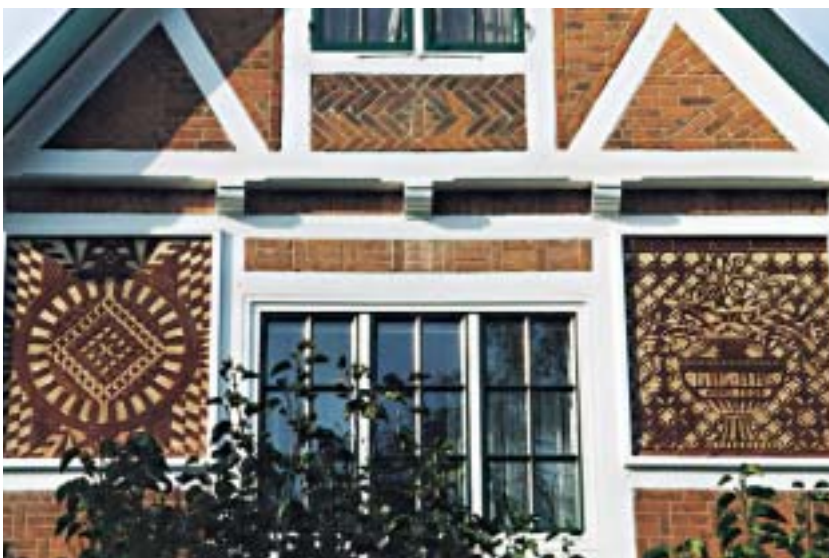
Abb. 59: Fachwerk, Schmuckverbände und Kratzputzfelder am Kirchstegel/Altengamme (Im Stil der Heimatschutzbewegung um 1910)
