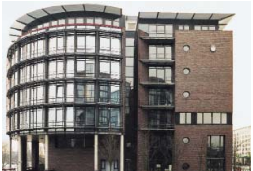
Abb. 231: Der Gebäudekopf von Nr. 73 zur Wendenstraße
