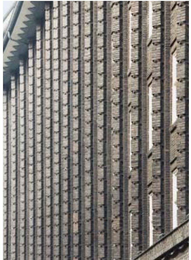
Abb. 130: Steinwechsel nach jeder sechsten Lage: Pfeilerfassade am Chilehaus
