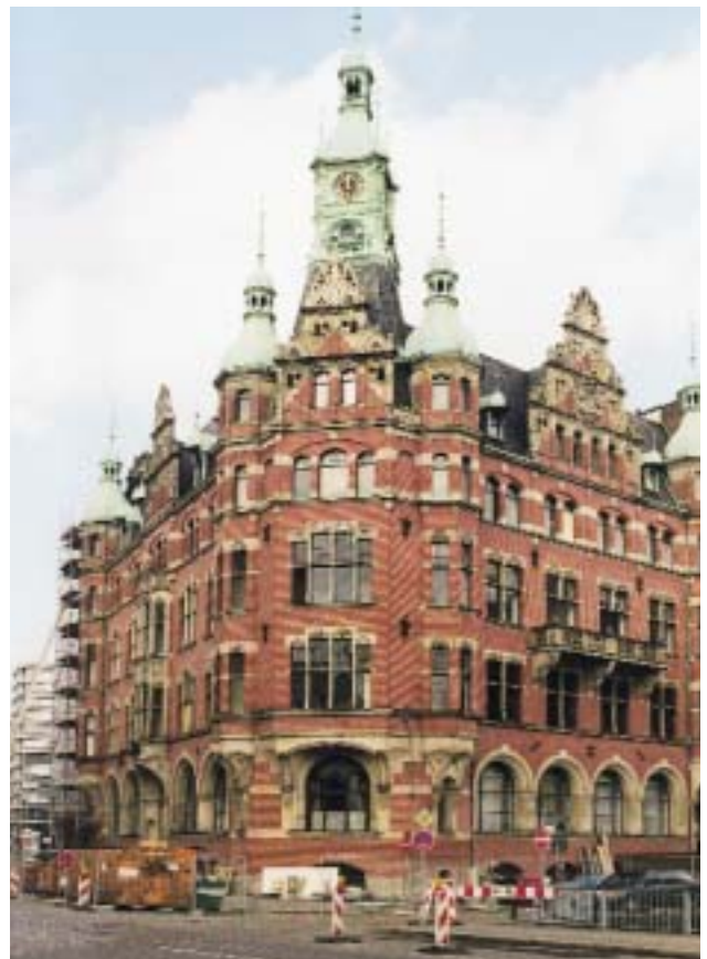
Abb. 208: Aufgipfelung der Fassade zum Eckturm: Das „Rathaus“ der Speicherstadt bei St. Annen
