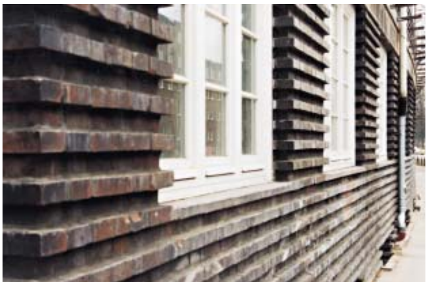
Abb. 116: Sockelgeschoss eines Mietshauses an der Kieler Straße
