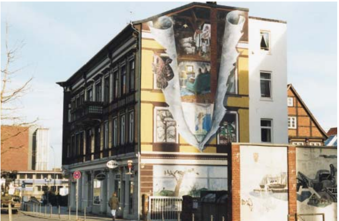
Abb. 187: Einblicke ins Innenleben eines Mietshauses an der Ecke Neue Straße/Lämmertwiete/Harburg
