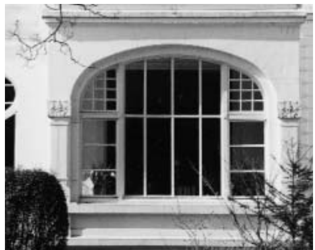
Abb. 92 a: Fassadendetail, Fenster im Erdgeschoss
