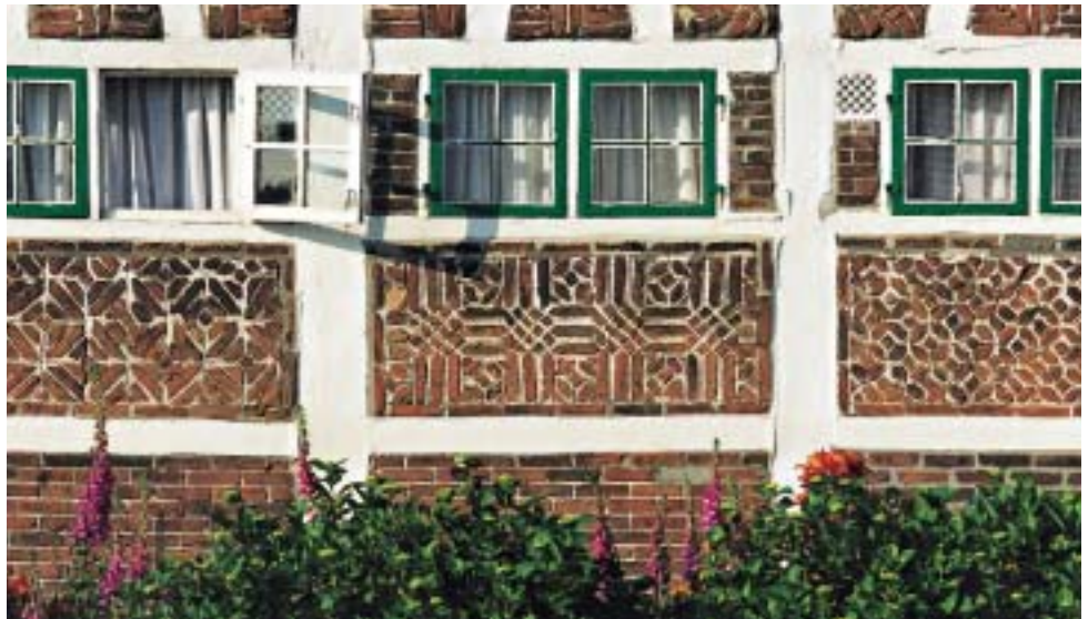
Abb. 52: Detail von Abb. 51: Die Ausfachung
