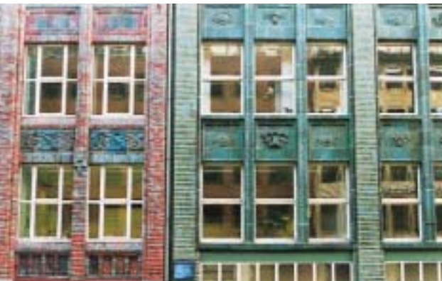
Abb. 127 b: Fassadendetails: Grès flammée-Glasursteine und Doppel-T-Träger
