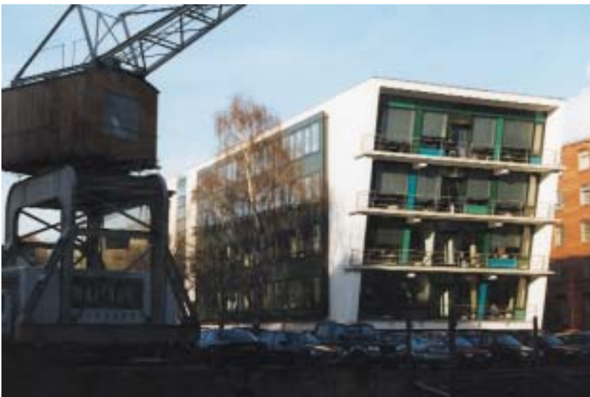
Abb. 183 b: Gebäudekopf des bbcom, Hafen Harburg
