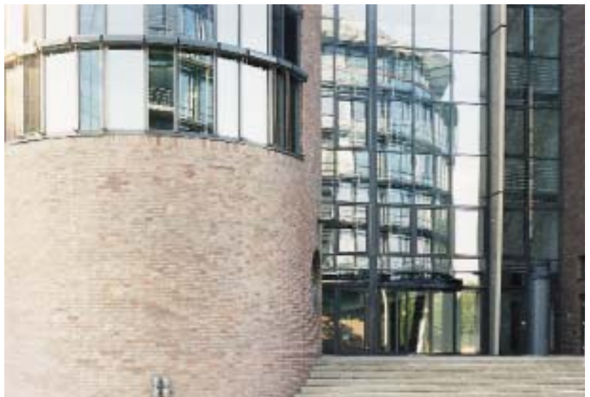
Abb. 230: Der Gebäudekopf von Nr. 51 mit der Spiegelung von Nr. 73
