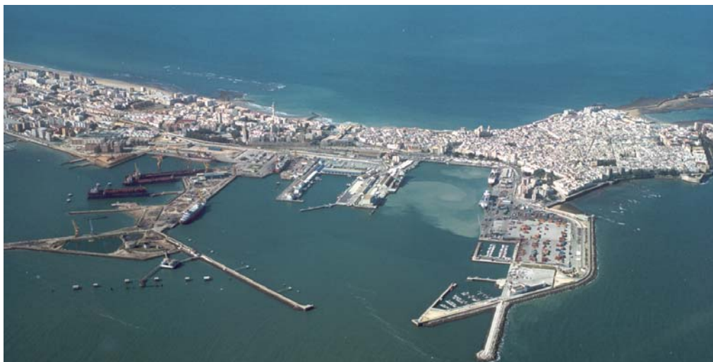
Hafen von Cádiz (Spanien) Quelle: Bay of Cadiz Port Authority
