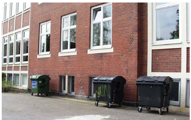
Falsch: Papiercontainer direkt vor Fenstern
