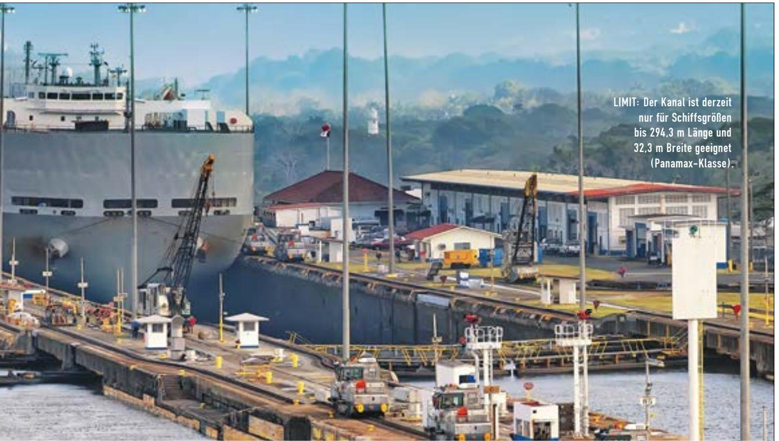
LIMIT: Der Kanal ist derzeit nur für Schiffsgrößen bis 294,3 m Länge und 32,3 m Breite geeignet (Panamax-Klasse).
