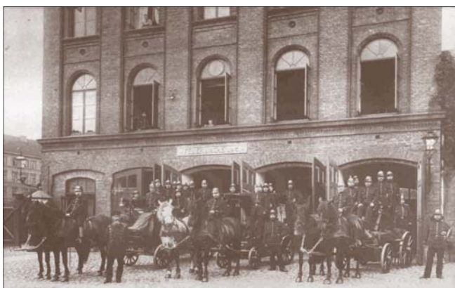
Feuerwache 5 Hohenfelde. Nach der Ausbombung im Sommer 1943 nicht wieder aufgebaut
