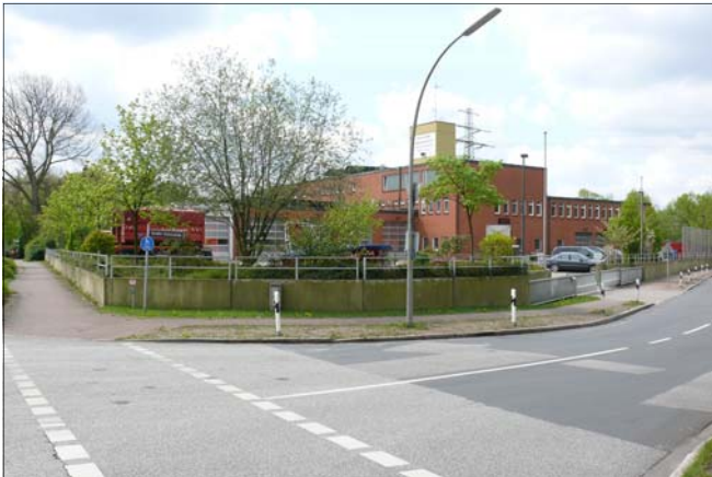
Technik- und Umweltschutzwache 32, Neuhöfer Brückenstraße 2, Neubau 1985
