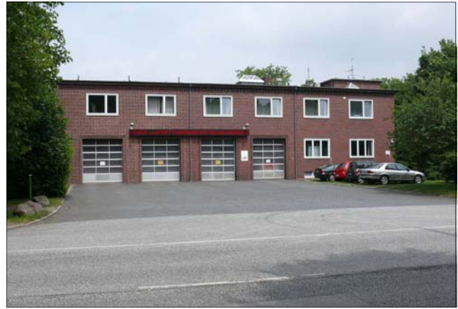
Feuerwache 34 Wilhelmsburg, Rotenhäuserstraße 73 Indienststellung 1930
