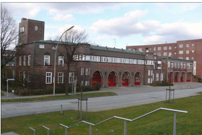
Feuerwache 33 Veddel, Am Zollhafen 11 - 13, Indienststellung 1928
