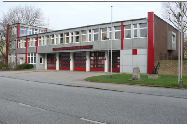
Feuerwache 12 Altona, Mörkenstraße 36, Neubau 1959
