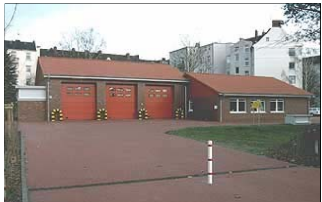
Neues Feuerwehrgerätehaus FF Eimsbüttel, 2007
