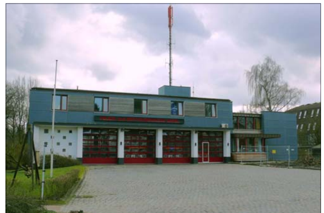
Feuerwache 24 Sasel, Saseler Kamp 2 Neubau 1963
