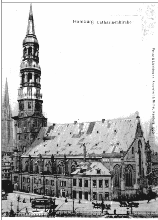
In dem Anbau der St. Catharinenkirche war die Wache 2 provisorisch untergebracht
