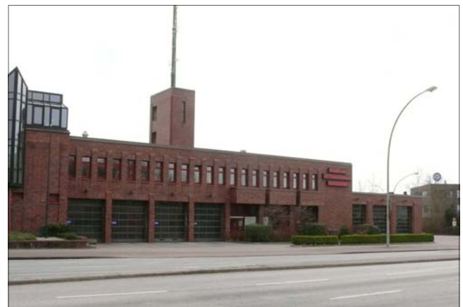
Feuerwache 26 Bergedorf, Sander Damm 3 Neubau 1991
