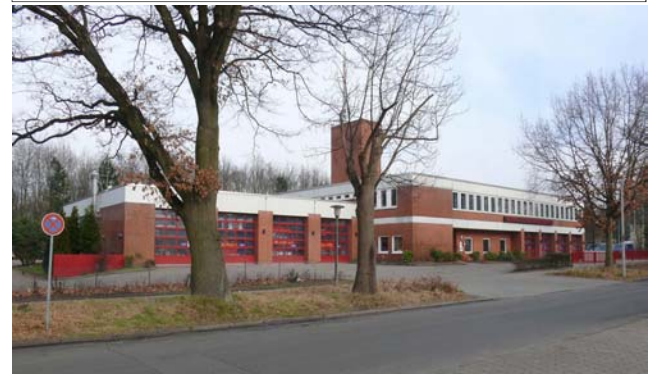
Feuerwache 14 Osdorf, Harderweg 10. Neubau 1979. Nach Indienststellung wurden die Wachen Ottensen und Blankenese geschlossen.
