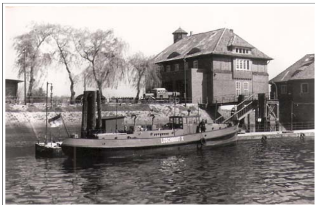
Feuerwache 14 Petroleumhafen, 1913 bis 1976
