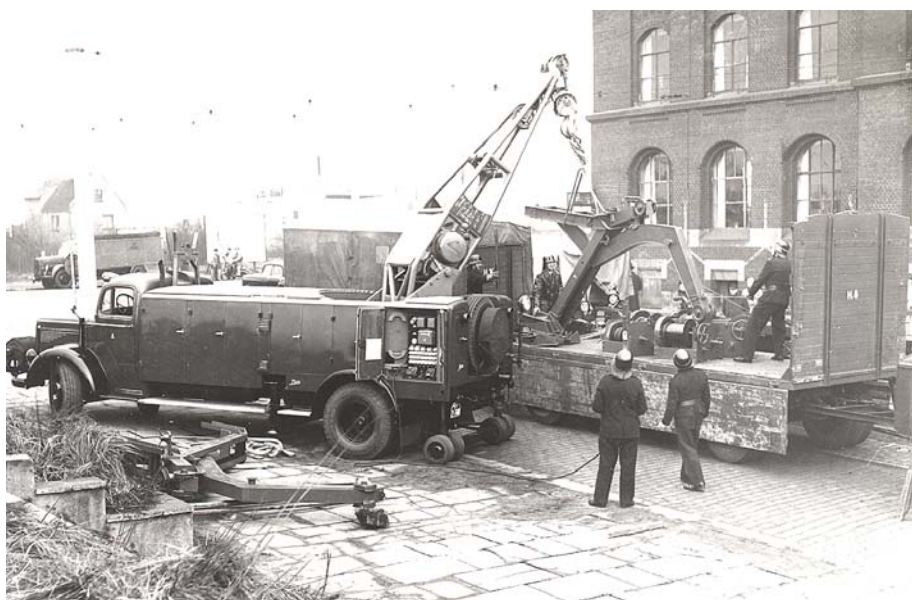
Der RKW 10 im Einsatz: Aufladen von herabgestürzten Stahlteilen (1)
