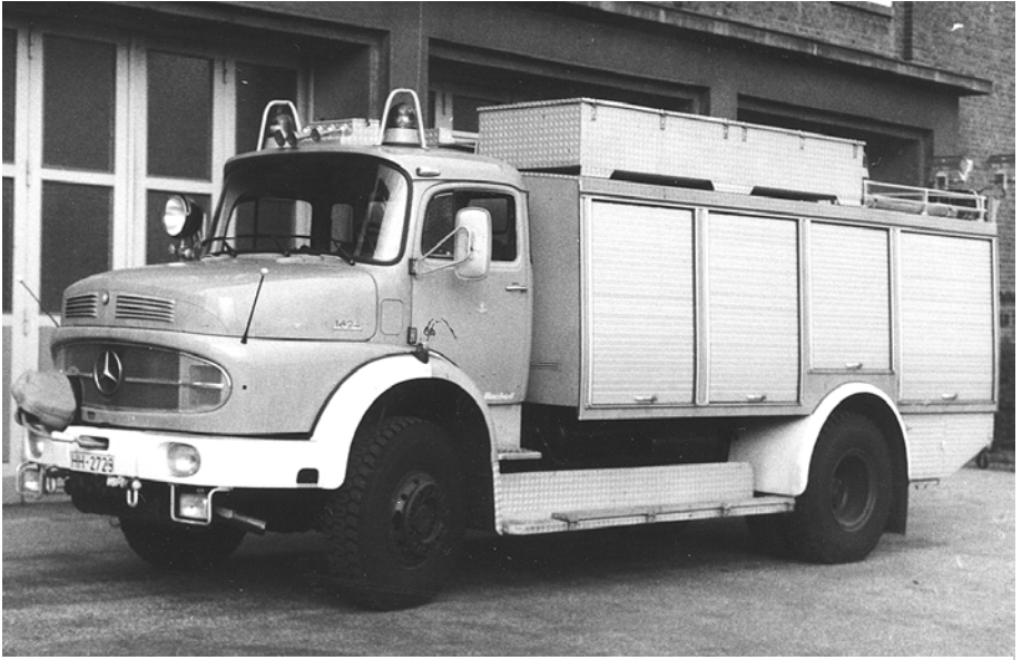
Rüstwagen RW 3 Fahrgestell: Mercedes-Benz LAK 1624, Aufbau: Bachert. Im Dienst von 1976 bis 1986 (4)
