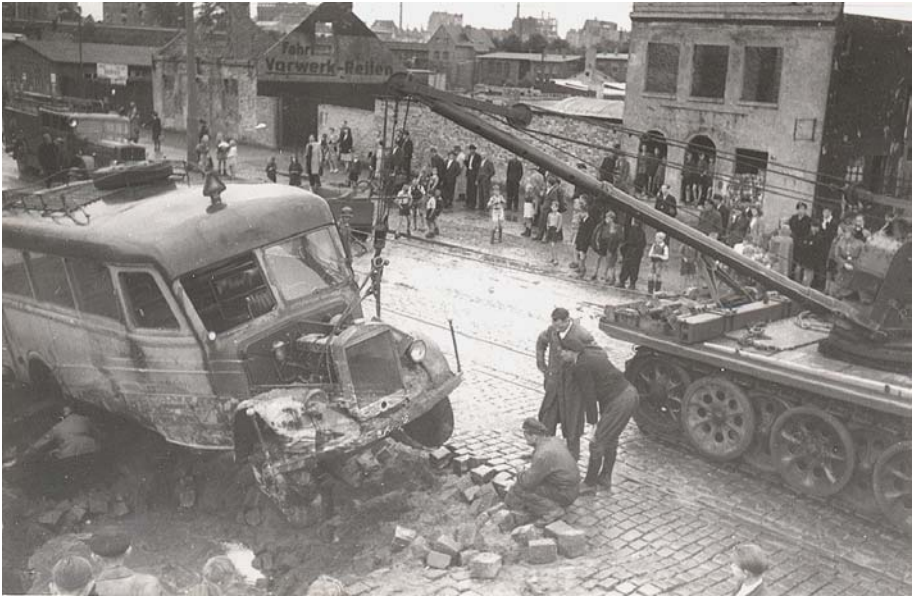
Einsatz des Zgkw am 18. 6. 1948 Bergung eines Autobusses aus einem Wasserrohrbruchtrichter (1)
