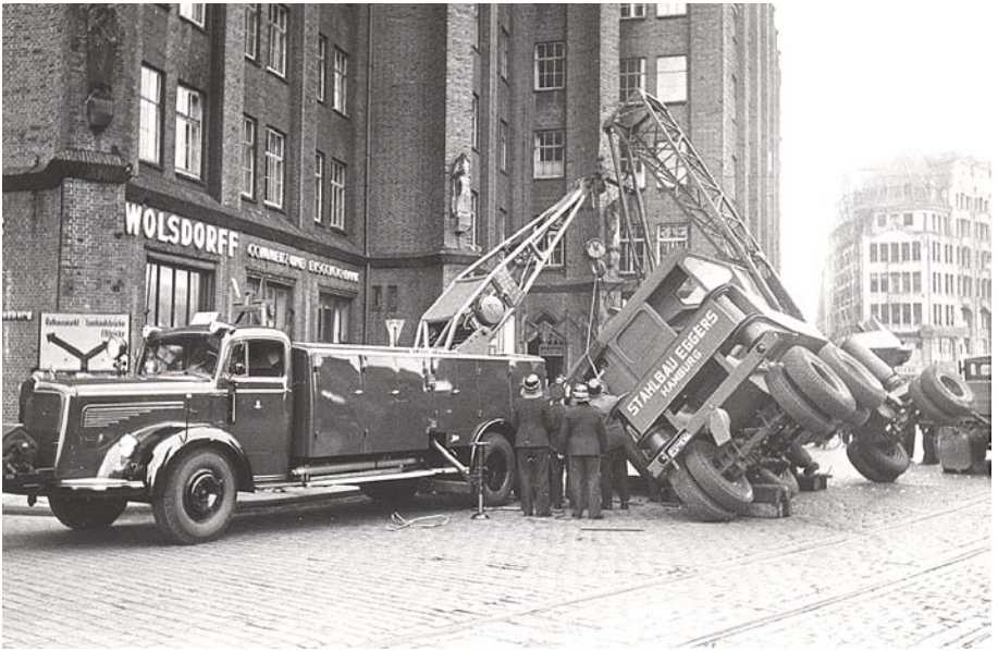
Der Rüstkrankenwagen RKW 10 im Einsatz: Aufrichten eines umgestürzten Kranwagens (1)
