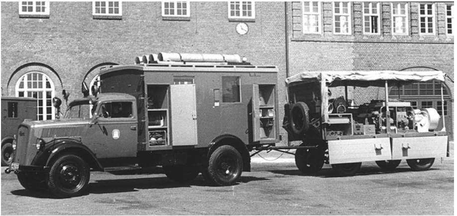
Der erste „Werkstattzug“ nach dem Zweiten Weltkrieg: Opel Blitz 3 t mit Kofferaufbauten und Anhänger.
