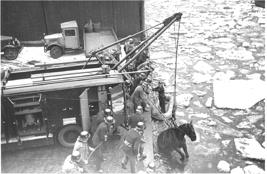
Bergung eines Pferdes mit dem RKW 4,5 aus dem Süderkanal in Hammerbrook am 9. 2. 1941 (1)
