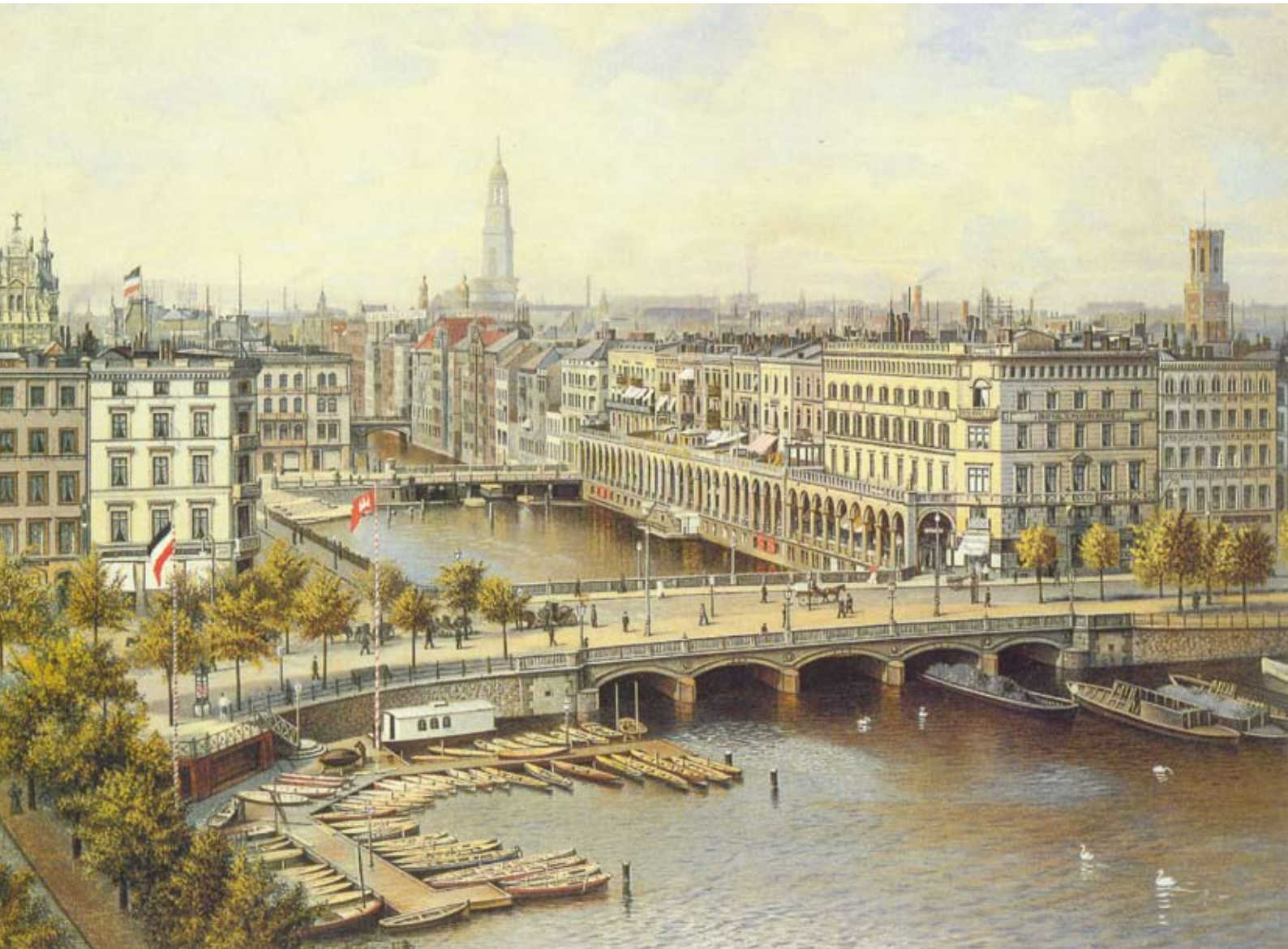
Blick um 1900 auf die nach dem Großen Brand neugestaltete Alster mit den Alsterarkaden.
