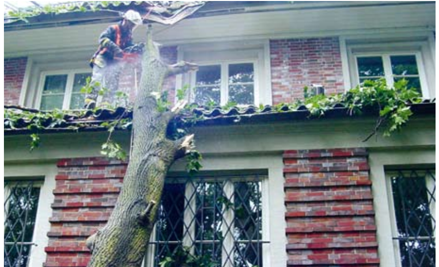
Umgestürzte Bäume nach einem Sturm beschädigen ein Gebäude.
