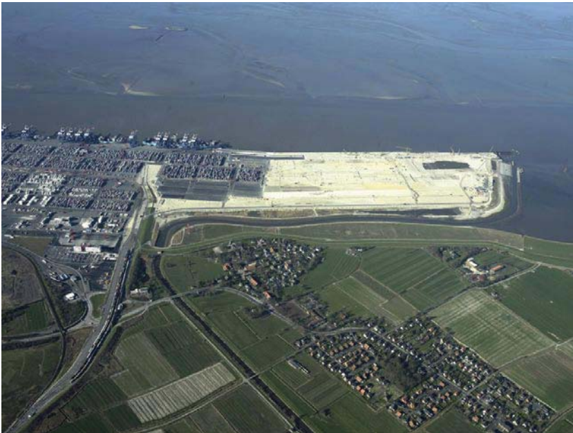
Abb. 1: Luftbild der Baumaßnahmen CT 4; Foto: Wolfhard Scheer
