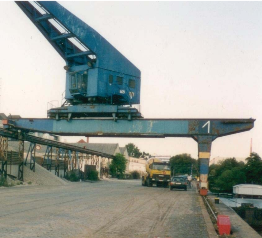
Bild 4: Kran mit aufgeständerter Kranbahn
