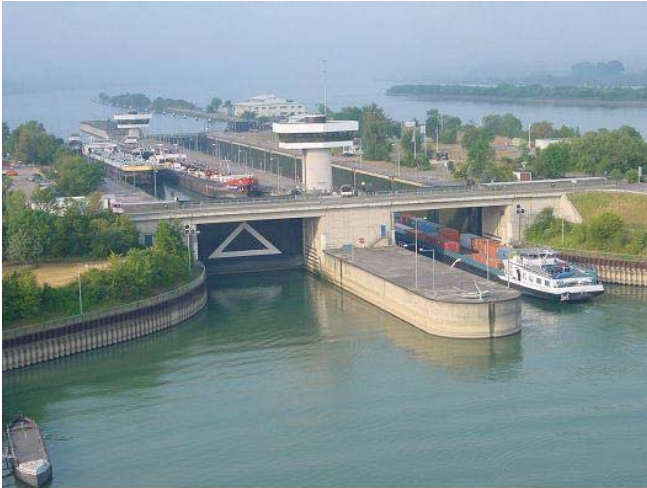
Abb. 1: Schleusenanlage Iffezheim mit Brücke B 500 (Quelle: WSA Freiburg)
