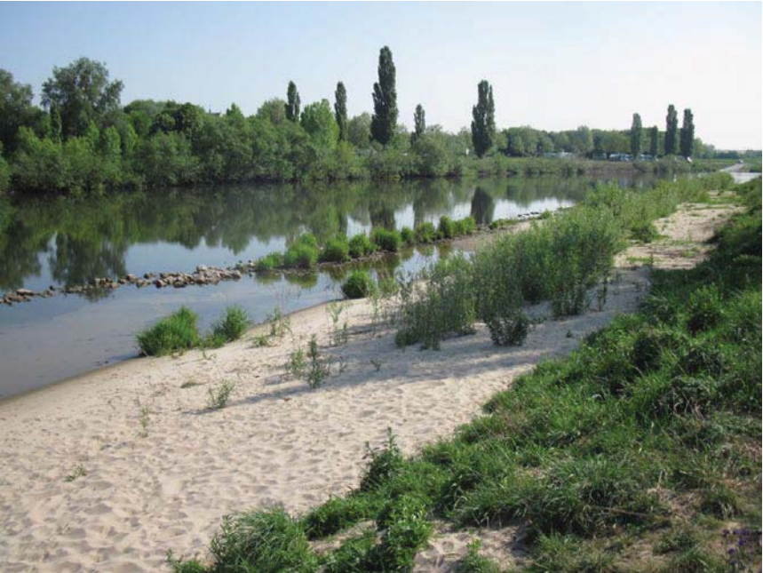
Abb. 11 Naturnah gestaltetes Ufer nach Uferzurücknahme
