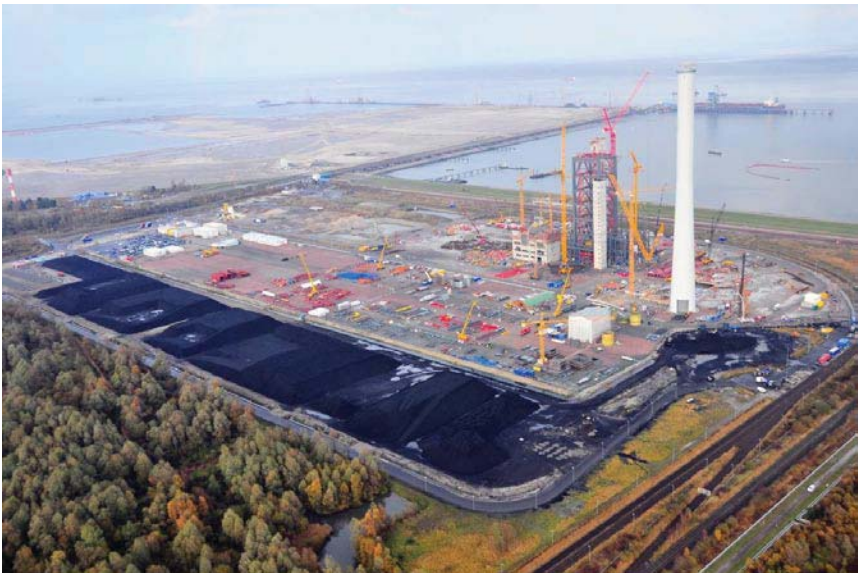
Bild 1: Kraftwerksbaustelle mit verlagertem Massenschüttgutlager im Jahr 2009 (Luftbild: Falcon Crest)
