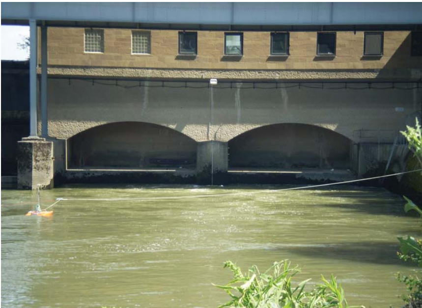
Bild 2: ADCP-Messung an der Stauanlage Lauffen, Blick von unterstrom auf den Kraftwerksauslass, links im Bild das Miniatur-Messboot mit dem ADCP-Messgerät.
