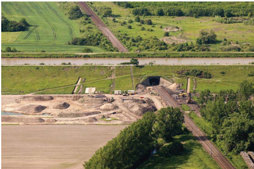
Die Kanalüberführung Elbeu vor Beginn der Bauarbeiten
