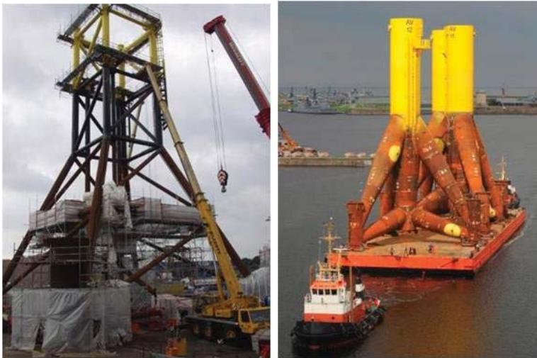
Abb. 3 + 4: Jacket-Struktur Umspannplattform und Tripod-Struktur „Alpha Ventus“
