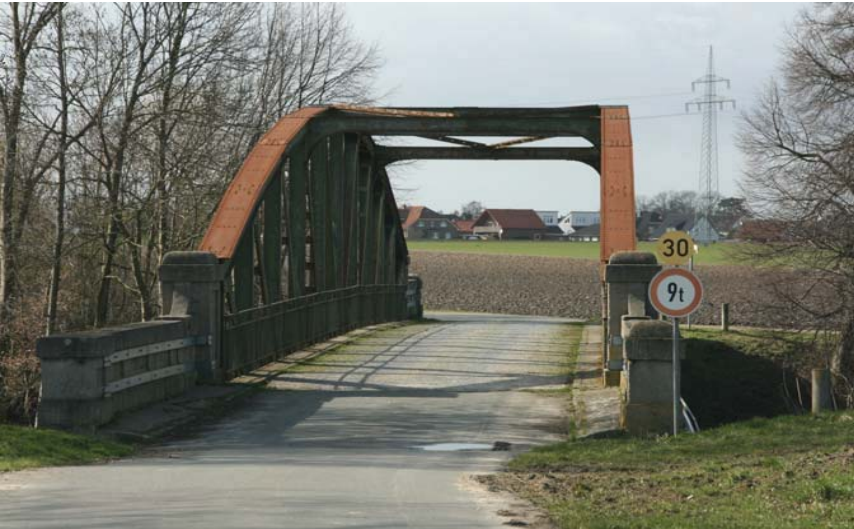
Abbildung 2: Wirtschaftswegbrücke Nr. 394 bei Hildesheim
