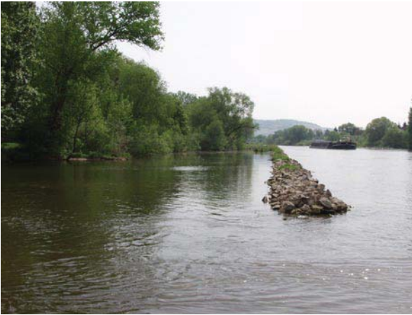
Abb. 7 Aufgehöhhtes Parallelwerk mit geschützter Wasserfläche
