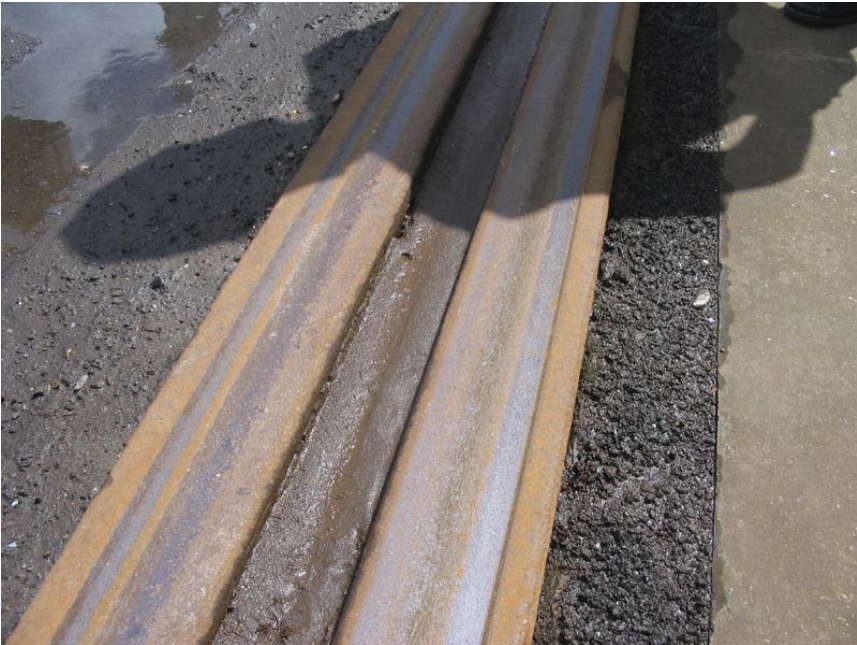
Bild 13: Doppelschiene für Containerkrane
