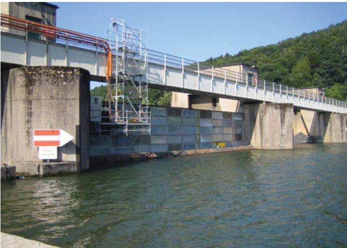
Abbildung 5: Wehr Steinbach - Feste Einhausung eines Wehrfeldes
