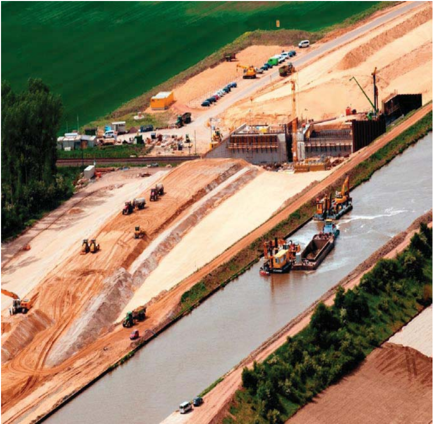
Ausweiche im Bau
