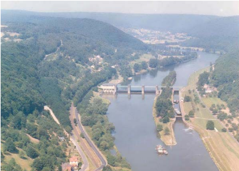
Abbildung 2: Luftbild Staustufe Rothenfels
