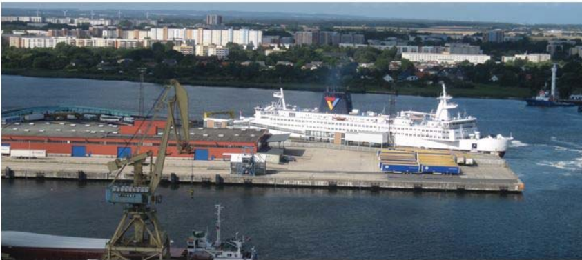
Abb. 6: Ansicht des Liegeplatzes 54 vor Beginn der Neubaumaßnahmen
