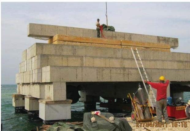
Bild 7: Durchführung statischer Pfahlbelastungstest
