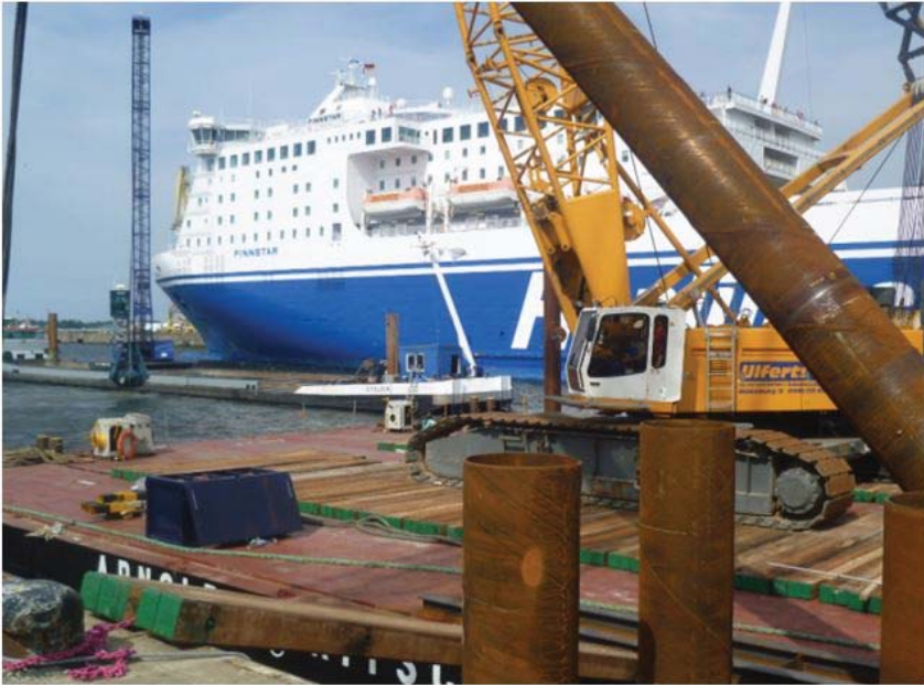
Abb. 13: Liegeplatz 54 in der Bauphase
