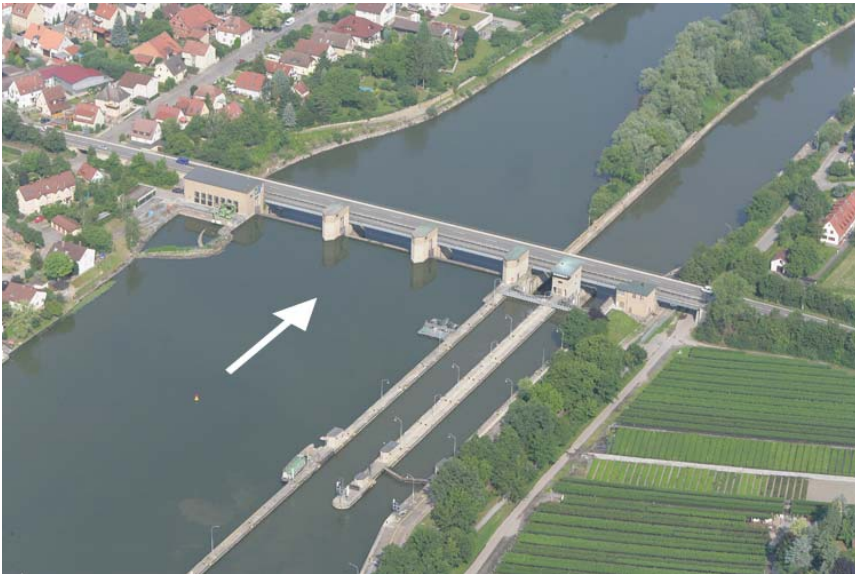
Bild 1: Staustufe Lauffen, Blick vom Oberwasser: links das Kraftwerk, in der Mitte das Wehr, rechts die Schleusenanlage (Quelle: Amt für den Neckarausbau Heidelberg).
