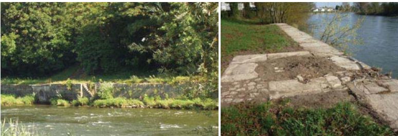
Abbildung 3: Ufermauer vom rechten Donauufer aus fotografiert (Foto: INROS LACKNER AG) – Historischer Kranstellplatz (Foto: WWA Donauwörth)
