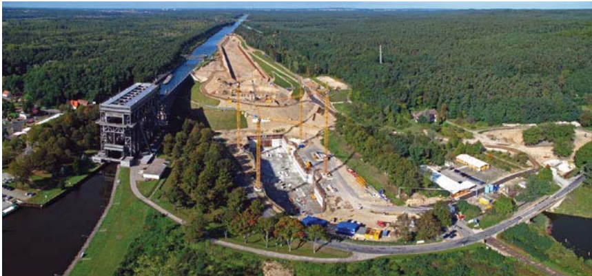
Bild 4 Luftbild der Baustelle
