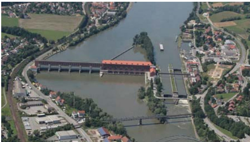
Abb. 1: Luftbild Staustufe Kachlet, von links nach rechts: Staustufe, Kraftwerk, Schleuse [Quelle: Stadtarchiv Passau]
