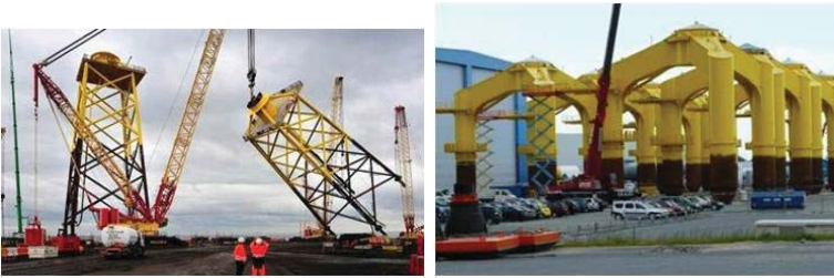
Abb. 5 + 6: Jacket-Struktur „Alpha Ventus“ und Tripile-Struktur „Bard Offshore 1“
