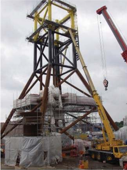
Abb. 22: Jacket der Alpha-Ventus Umspannplattform im Bau, Quelle: HOCHTIEF
