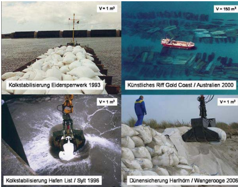
Abb. 2: Anwendung geotextiler Container aus vernadeltem Vliesstoff (VSC)
