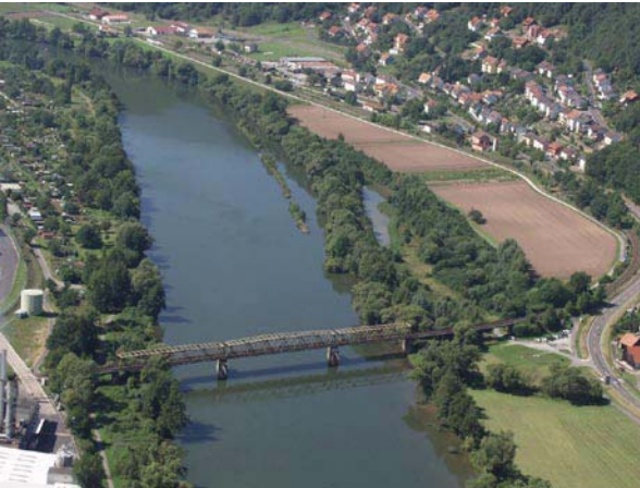
Abb. 9 Uferstrukturierung (rechts oberhalb Eisenbahnbrücke) mit fortgeschrittener Auwaldentwicklung
