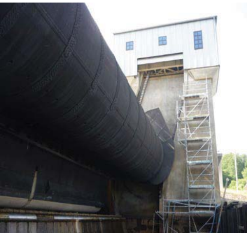
Abbildung 8: Wehr Viereth - Ansicht vom Unterwasser Wehr R
