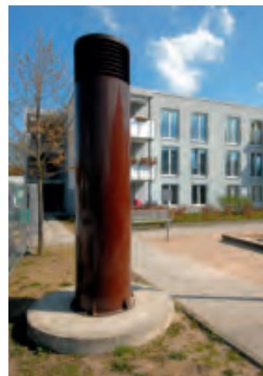
Ein Luft-Ansaugstutzen sorgt für die richtige Be- und Entlüftung der Passivhäuser in der Riefsiedlung
