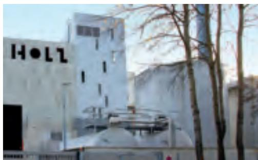
Biomasse-Heizkraftwerk in Lohbrügge: Das bestehende Gas-Fernheizwerk versorgt rund 8.000 Wohnungen, Gewerbe und öffentliche Einrichtungen mit Fernwärme. Zusätzlich errichtete die Firma KWA Bioenergie GmbH & Co in Kooperation mit SAGA GWG 2008 ein Holz-Heizkraftwerk zur Strom- und Wärmeerzeugung. Die Anlage wird mit naturbelassenem Waldholz betrieben.
