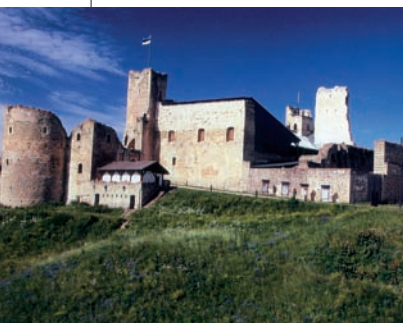
Ruine der Ordensburg Wesenberg
