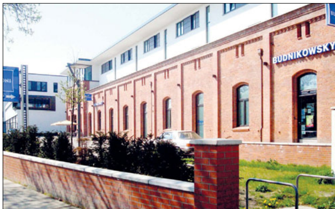
Die Fassade der Pferdeställe von der Rennbahnstraße gesehen. Sie wurden um ein Stockwerk erhöht und bieten Räumlichkeiten für den Bäcker Dat Backhus und den Drogeriemarkt Budnikowsky.
