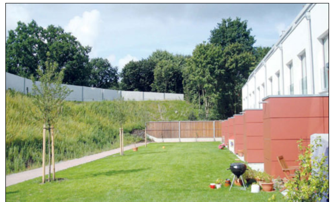
Oben: Im Innenbereich, umgeben von Neubauten, sind im Hintergrund die umgebauten Pferdeställe zu sehen. Unten: Blick in die Reihenhäusgärten an der Autobahnseite.
