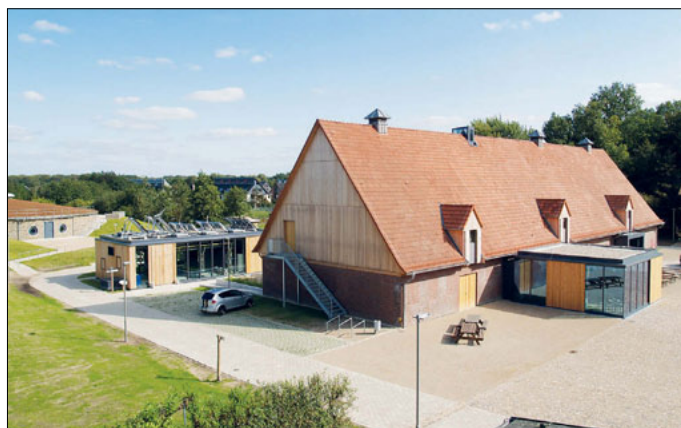
Das renovierte Stallgebäude. Dahinter links das Gläserne Energiehaus und am Bildrand der Wärmespeicher mit Dachbegrünung.
