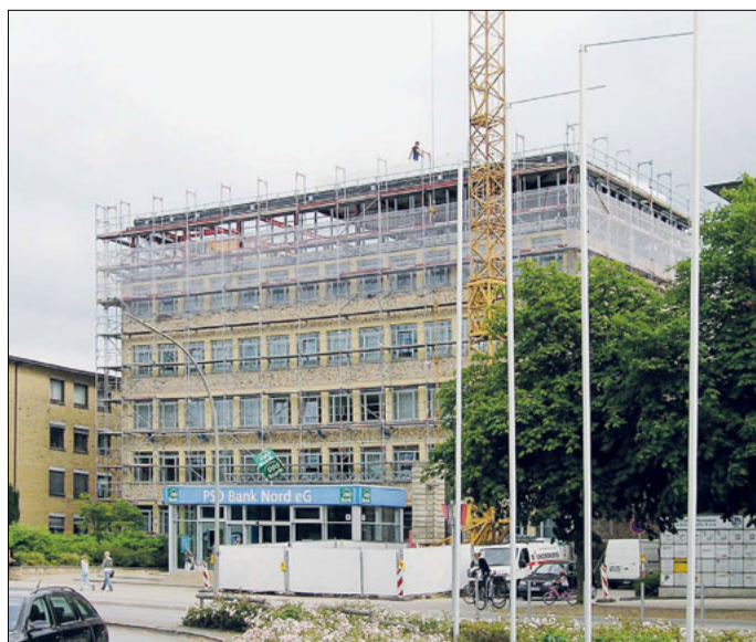
Anfang Juni wurden die Stahlträger für das neue 5. Stockwerk der PSD Bank Nord-Zentrale in der Schloßstraße 10 eingezogen.
