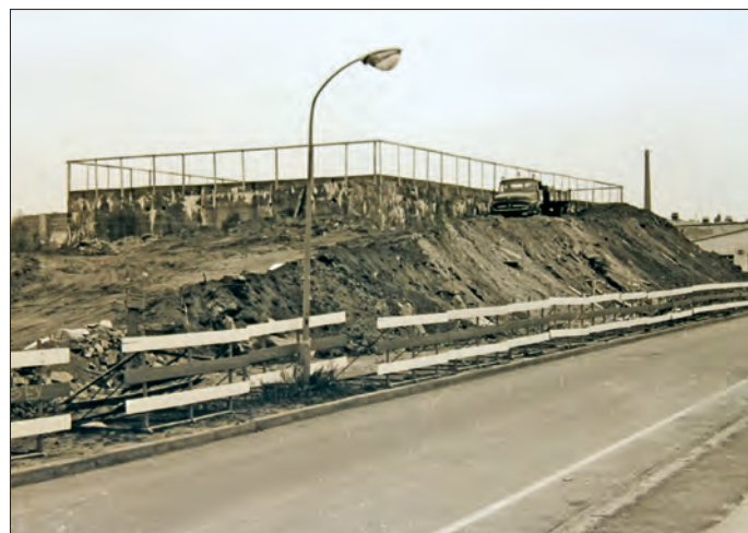
Ein Lkw fährt auf einer Rampe Erde zur Eindeckung des Bunkers heran. Archiv K. Pincker
