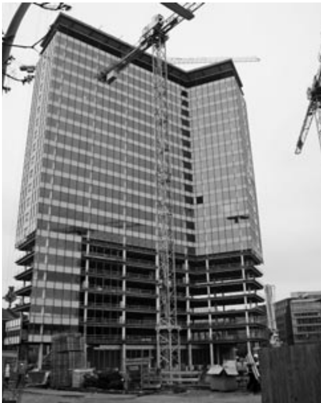
Umbauarbeiten im Jahre 2010 am 1961 erbauten „Unilever-Haus“, heutiger Name „Emporio“. PHOTO: MARINA BRUSE
