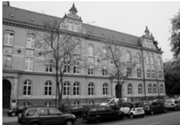
Gorch-Fock-Wall 15–17: Ehemaliges Dienstgebäude der „Behörde für das Versicherungswesen“, erbaut 1895.
