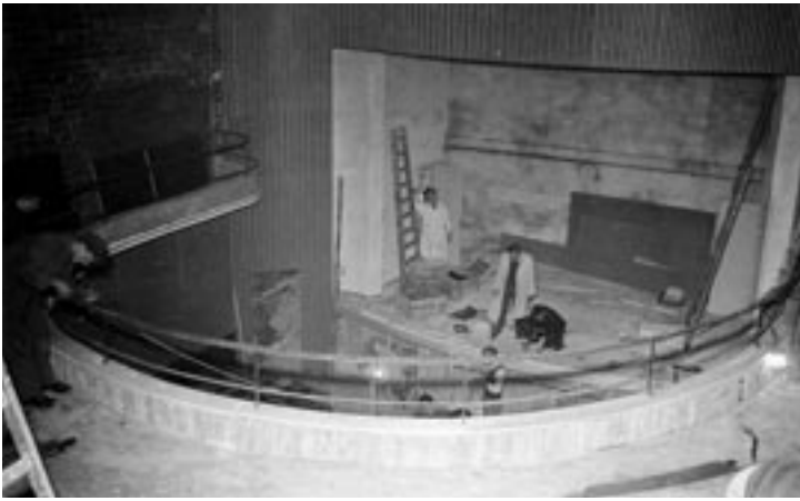
Beim Bau des Filmkunsttheaters „Metropolis“ 1951.
