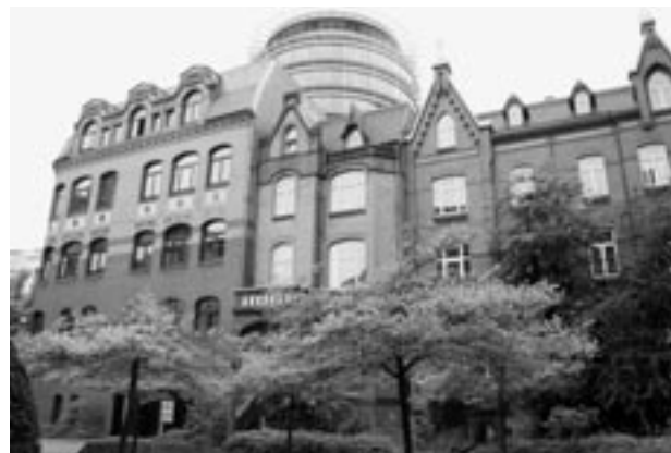
Heute am St. Anscharplatz. Einige alte Gebäude stehen noch. Siehe auch die Postkarte aus der Zeit Anfang des 20. Jh., Seite 179. PHOTO: MARINA BRUSE
