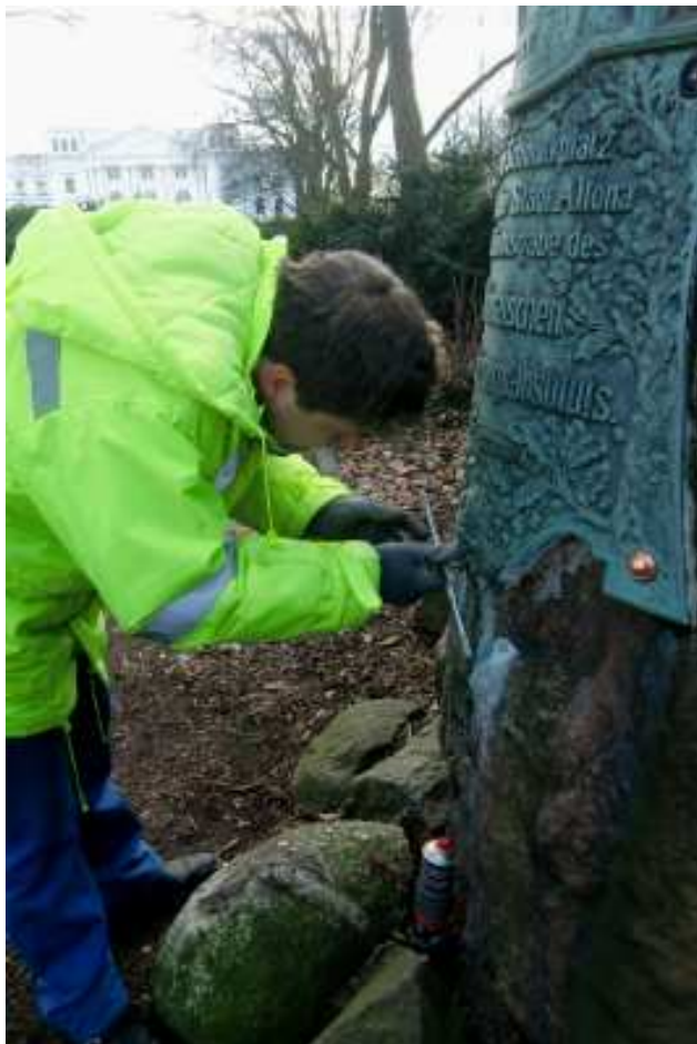
Herr Evers dreht mit einem Handgewindeschneider ein neue Gewinde in die Bohrlöcher
