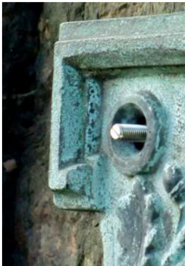
Der perfekt eingesetzte Gewindestab
