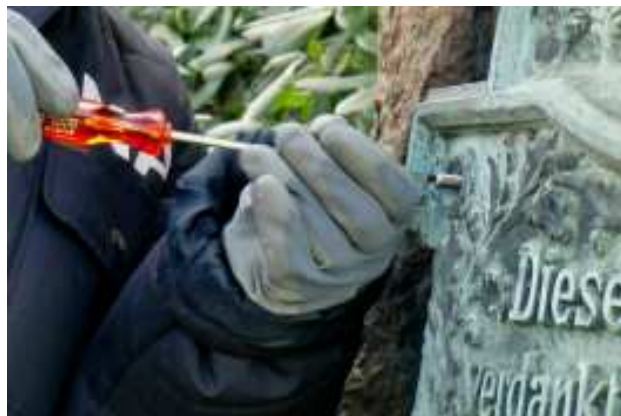
Mit einem Schraubendreher schraubte Herr Marksch den Gewindestab in das Bohrloch oben links
