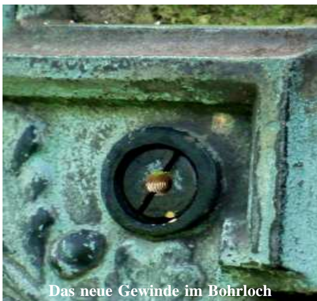
Herr Evers dreht mit einem Handgewindeschneider ein neue Gewinde in die Bohrlöcher
